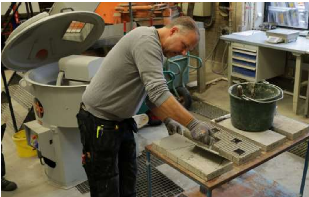
Figur 3.1. Applicering av fästmassa på betongunderlag i CBIs lokaler.
