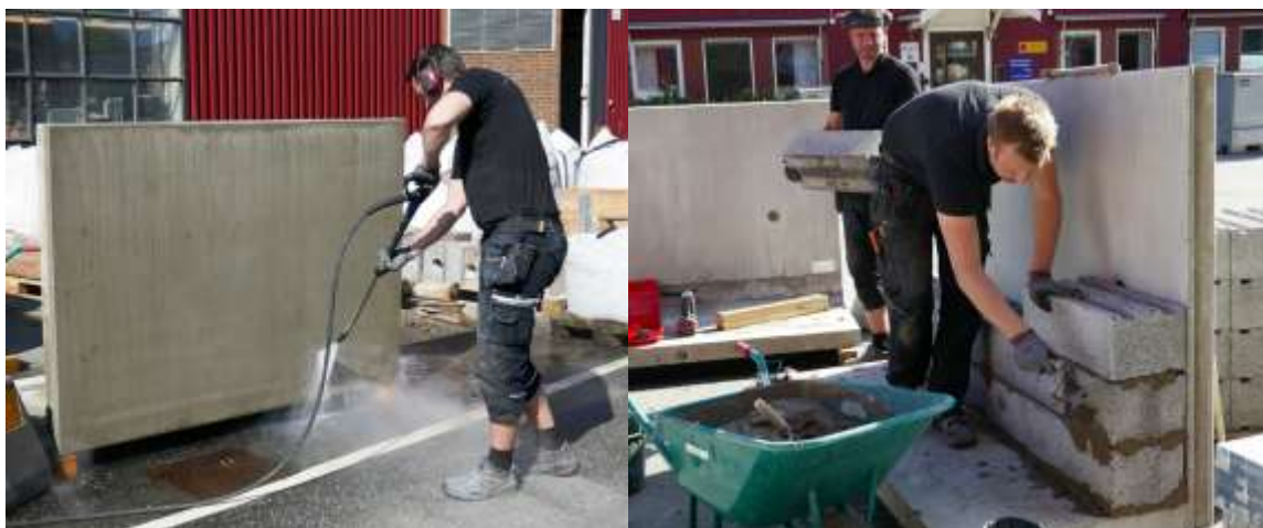
Figur 5.16 a och b. a: högtryckstvätt med varmvatten för att få bort ev rester av formolja. b: Murning med lättklinkerbetongblock
