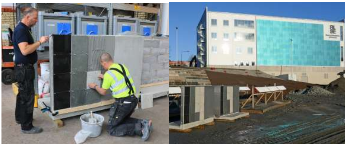
Figur 15.7 a & b. a: Närkesten monterar plattor på L-stöd av betong. b: Färdiga L-stöd, med stenplattor och skyddsplåtar, placerade vända mot sydväst på RISE fältprovplats ca 100 m från RV40, vid västra infarten till Borås.
