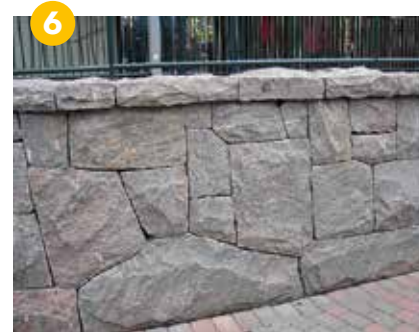
Kryssmur. Oregelbundna månghörningar.
