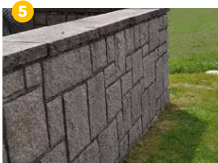
Rubbelmur. Rätvinkliga stenar i ojämna skift.
