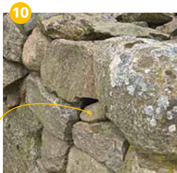
Skolstenen är en kritisk detalj i en kallmur av fältsten eller sprängsten.
