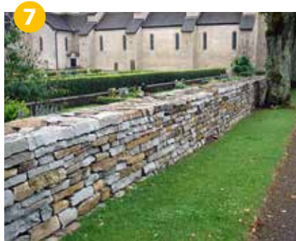
Mur av staplade skivor. Oftast kalksten eller skiffer.
