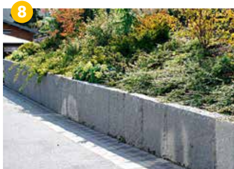
Blockstensmur (enskiftesmur). Hela rätvinkliga block eller skivor.
