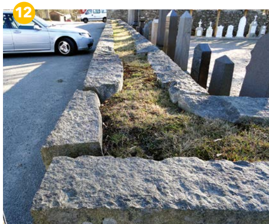
Skalmur som är på väg att "kalva" eftersom den saknar bindare.
