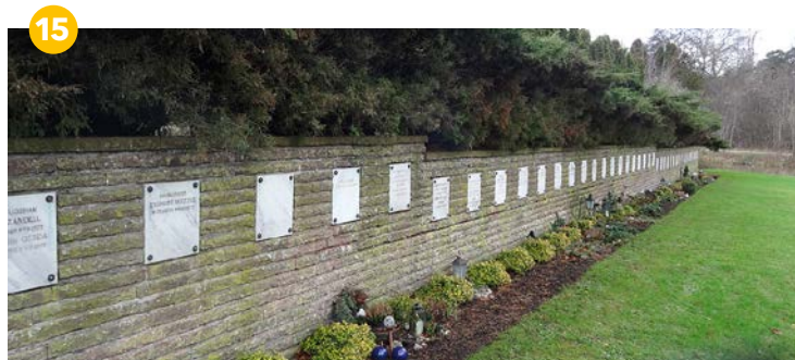
Bruksmur av staplade kalkstensplattor som inhyser kolumbarium med marmorluckor.
