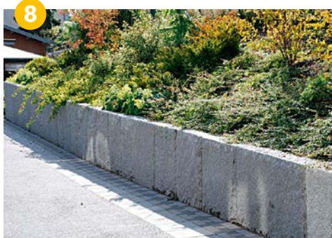
Blockstensmur (enskiftesmur). Hela rätvinkligna block eller skivor.
