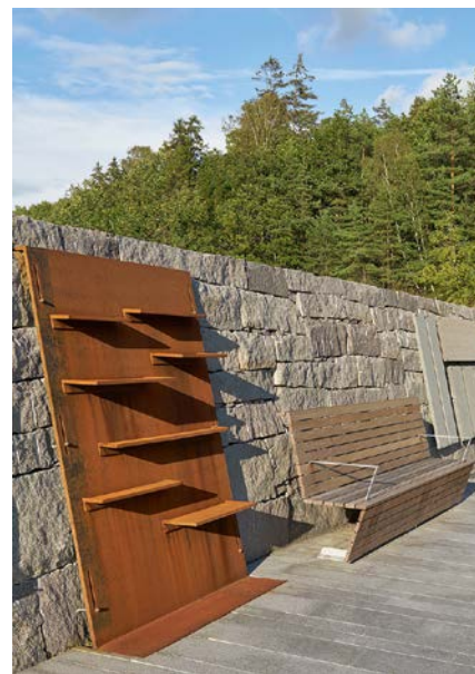
▲ Stålplåtar med utskurna hyllor för gravljus lutar mot kallstensmuren.
