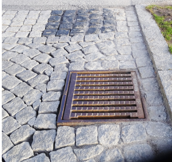
Figur 2 Brunnsgallret ligger högre än omgivande stenyta, vilket resulterar i att vattenavrinningen inte fungerar.
