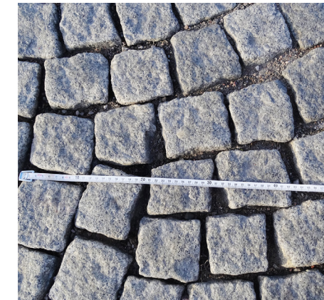
Figur 4 Dålig passning av stenen. För stora fogar, vissa fogar är 30 mm, andra 0 mm. Rätt bredd: 9 +/- 5 mm.
