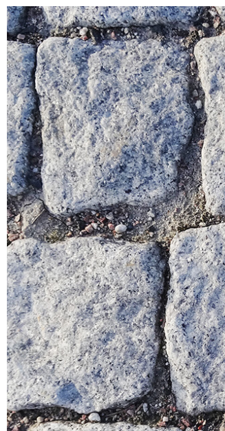
Figur 3 Fog- och sättmaterial har stor andel finmaterial som tätar till så att vattnet stannar i ytan.
