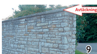
Fristående bruksmur med avtäckning.
