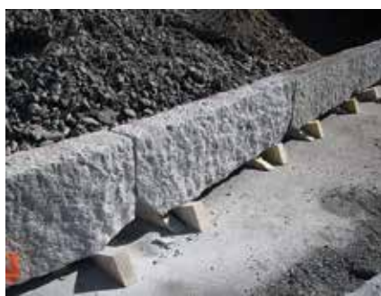
Uppsalas upphandling omfattar granithällar, gatsten och kantsten.
