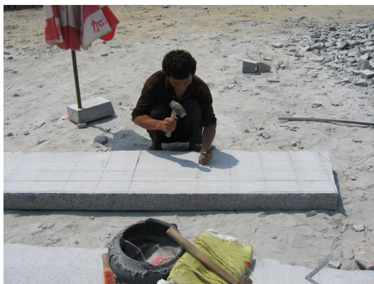
Figur 12 Kilning av flammad skiva till gatsten.
