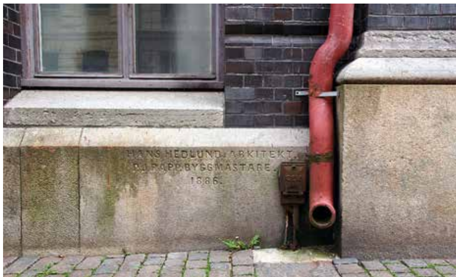
Schillerska gymnasiet i Göteborg har sockel i Bohusgranit mot gatan. Där står det inhugget att byggnaden uppfördes 1886. I dag sitter dock denna sockelsten i en utbyggnad från 1911. Troligen har man flyttat den för att den inte skulle bli gömd.
