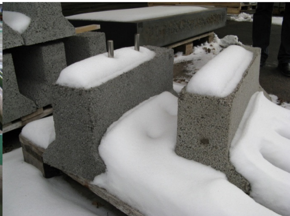
Bild 16. Fundament av lecabetong med gravvårdsdubbar.
