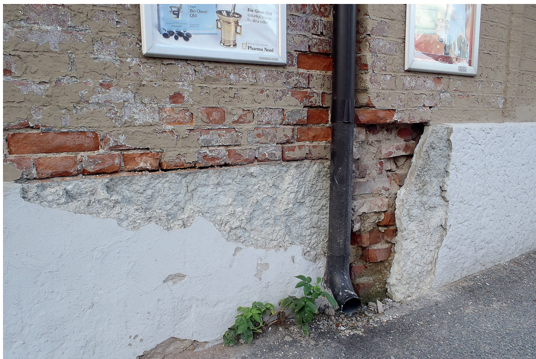
FIGUR 7. Landshövdingehuset vid Kapellplatsen (k i Fig. 1), byggt 1887, har en grå ortoceratitkalksten som sockel. Kalkstensblocken står på högkant vilket medfört en ödesdiger vittring. Särskilt sker detta om kalken är mörk (lerig). Man har målat kalkstenen, troligen för att skydda den, dock har det inte hjälpt i detta fall. Kalkstensytornas karaktäristiska textur går här att urskilja bakom den tunna målningen. FOTO: Erik Sturkell.
