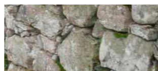
Fig 6. Fältstensmur. Kan också bestå av sprängsten.
