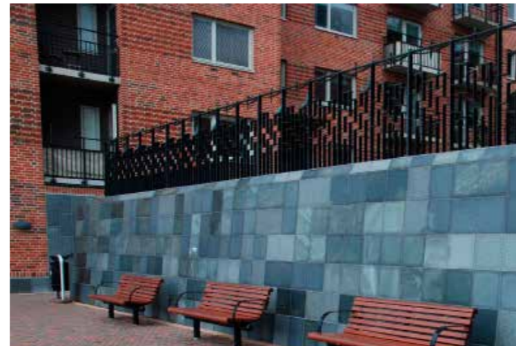
Beklädnadsmur, 30 mm plattor av Offerdalsskiffer. Sörhallskajen, Göteborg. FOTO: CHRISTER KJELLEN
