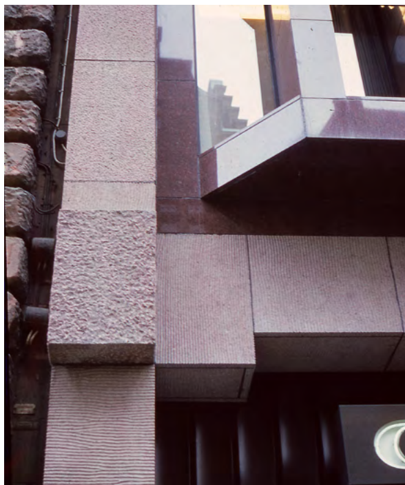
Polerad, krysshampad, pikhuggen och randmejslad yta på samma röda granit ger kontrast i fasadbeklädnad.
