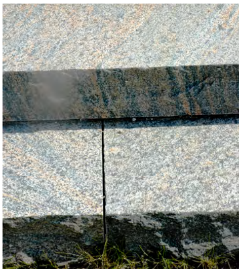
Trappsteg med flammad ovalsida (plansteg) och råkilad framsida (sättsteg) ger kontrastverkan och markerar trappans steg.
