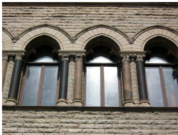
Kalkstensfasad med olika ytbearbetningar, polerade granitpelare.
