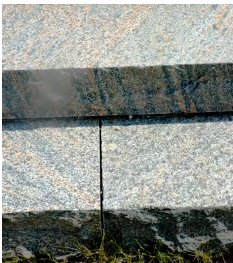
Trappsteg med flammad ovsida (plansteg) och råkilad framsida (sättsteg) ger kontrastverkan och markerar trappans steg.
