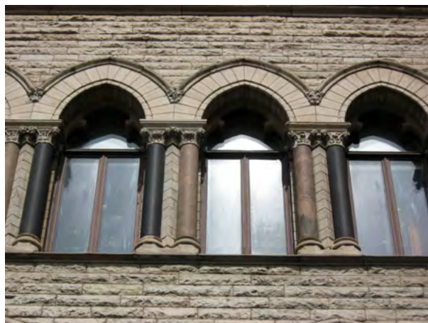
Kalkstensfasad med olika ytbearbetningar, polerade granitpelare.
