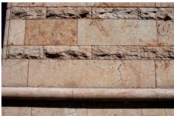
Lägerhuggen och dubbelstucken mursten, skrädhuggen list, kalksten, Strandvägen, Stockholm
