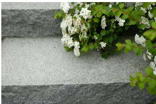
Blocksteg av granit med krysshamrad ovansida (plansteg) och råkilad framkant (sättsteg)
