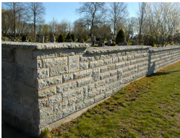
Bruksmur av dubbelstucken kalksten med avtäckning där synlig kant är dubbelstucken.
