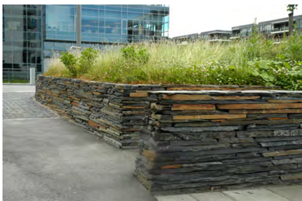
Kallmur av staplade skifferplattor med bräckt kant.
