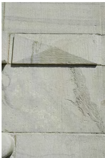
Lägerhuggen och dubbelstucken mursten, skrädhuggen list, kalksten, Strandvägen, Stockholm
