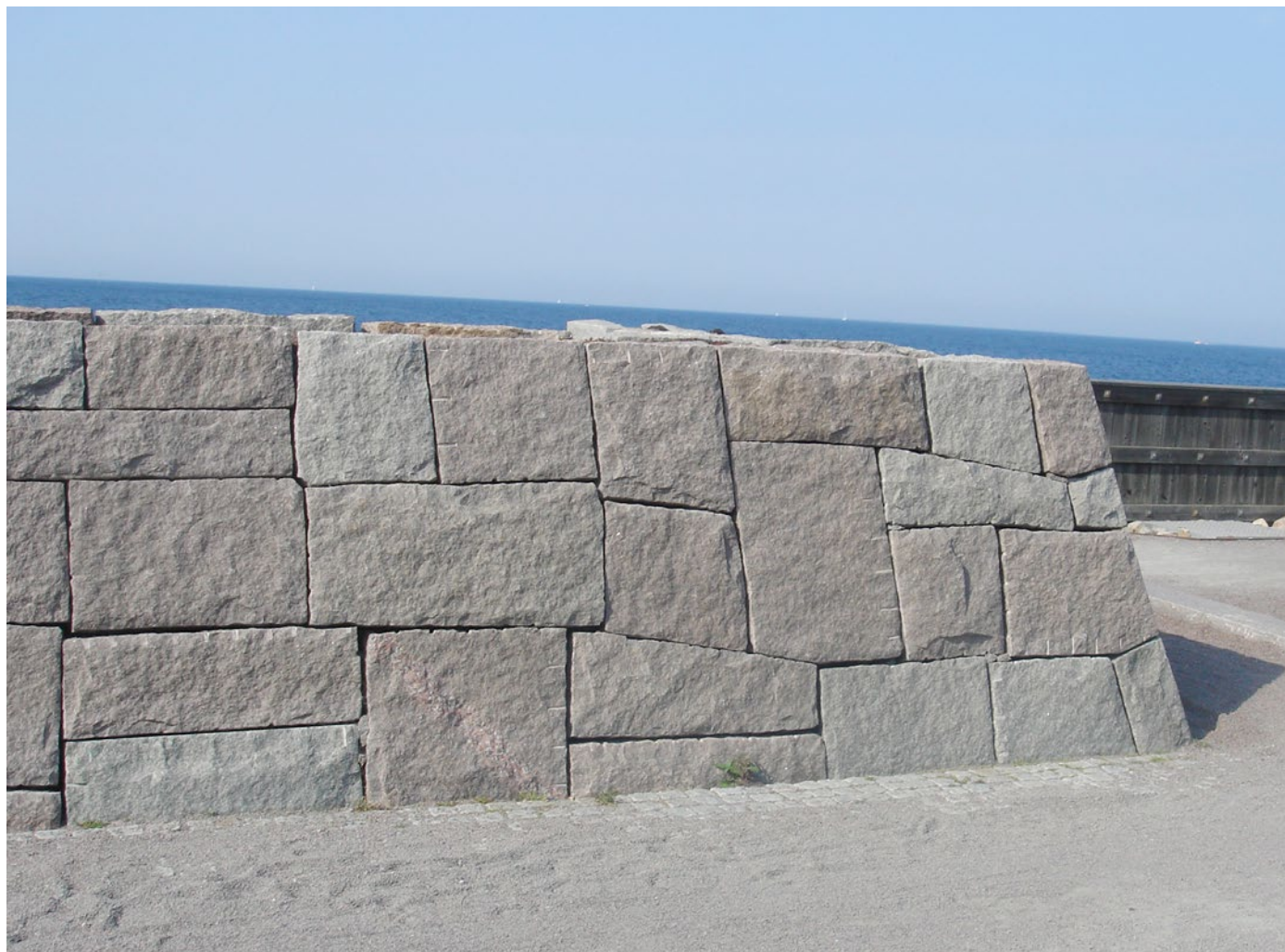
En rubbelmur där råkilade ämnen satts till en mur. Numera är utbudet av stensorter med olika egenskaper väldigt stort, och antalet monteringsföretag har också ökat. I ett stenprojekt avgörs resultatet både av råvarans kvalitet och av monterings utförande. Därför har besiktningsmannens roll och kunskaper blivit viktigare, och det finns anledning att använda sig av besiktningsmän med dokumenterade kunskaper.
