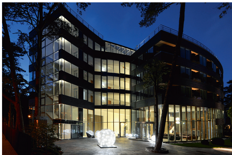
Offerdalsskiffer finns i hela byggnaden. Utomhus har även Oppdalsskiffer använts.
