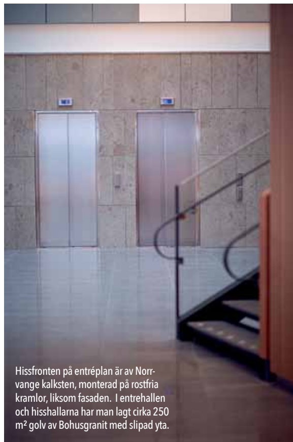
Golvet i entréplan bygger på samma bokryggsidé som fasaden. Golven är monterade i sättbruk.
