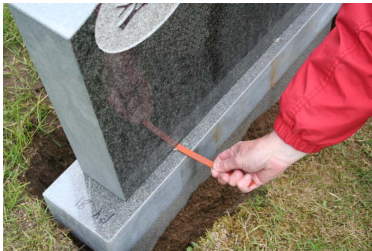
Figur 8. Kontroll av antalet dubbar med bågfilmsblad
