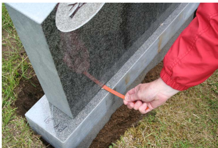
Figur 16. Kontroll av dubbar med bågfilmsblad.
