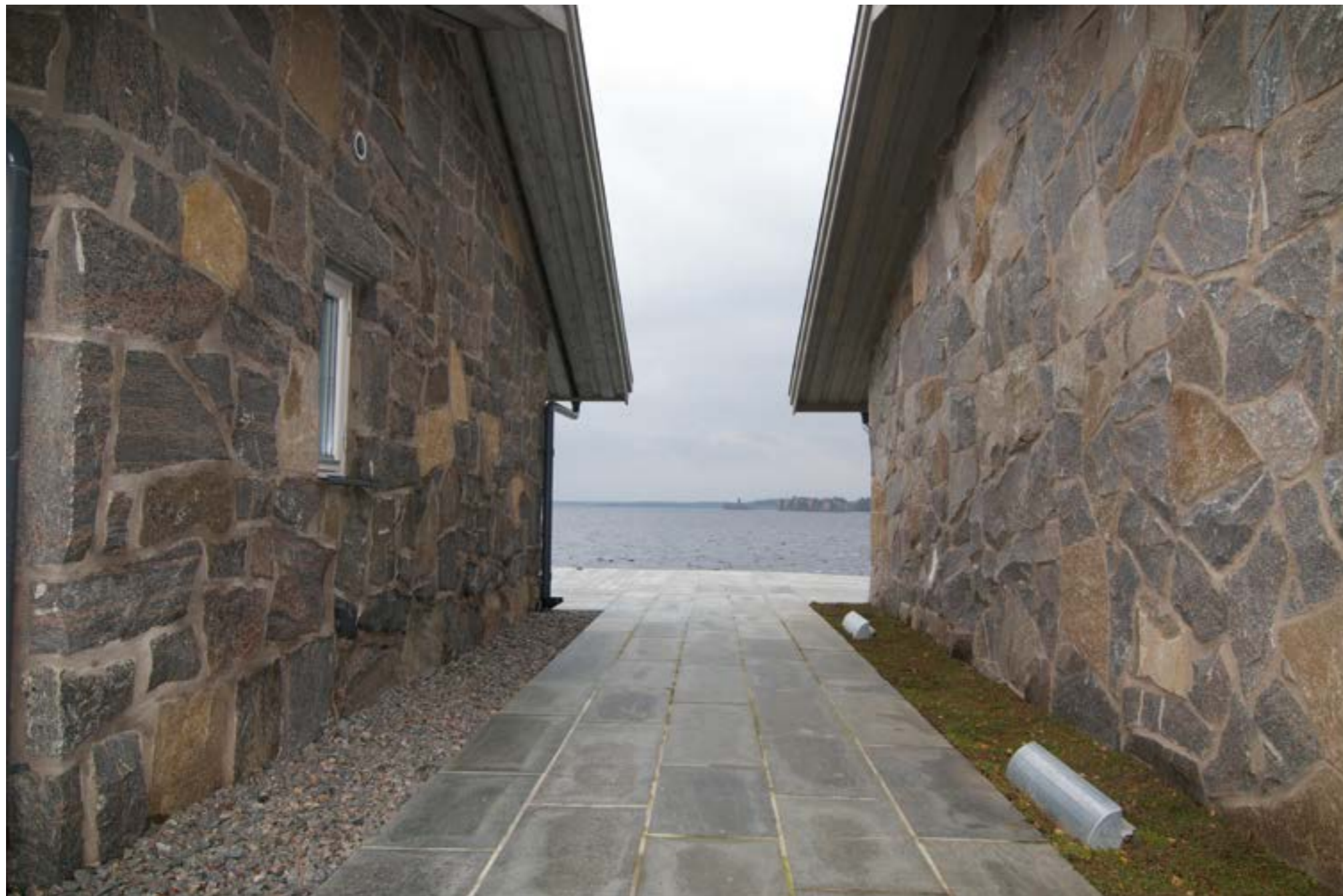
Stenfasad i "svallen" av halländsk granit. Den närmaste huskroppen är nybyggd medan den bortre är 20 år.
