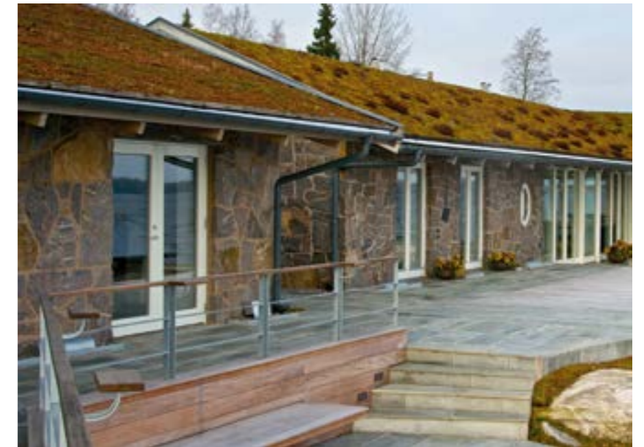
Stenfasad i "svallen" av halländsk granit. Den närmaste huskroppen är nybyggd medan den bortre är 20 år.
