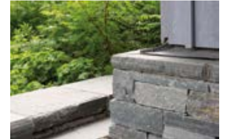
Byggnadens sockel består av Offerdal Torrmur 50-200 mm, krönsten Offerdal natur med fallande längder x 70 mm med bräckt synlig kant och sågade fogsidor. Foto Robert Kjellén
