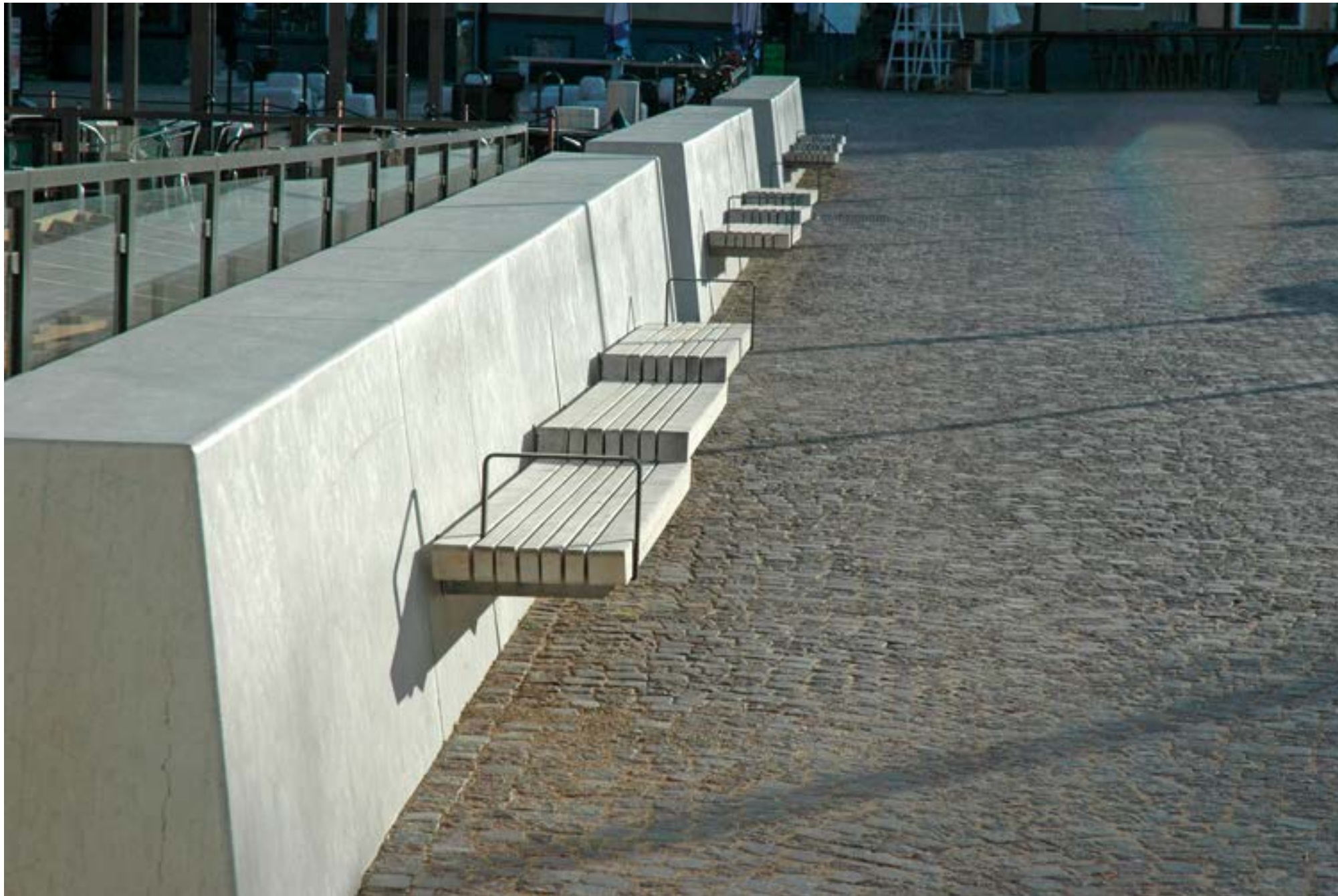
De massiva kalkstensmurarna med sittbänkar i söderläge hjälper till att ta hand om nivåskillnaderna mellan serveringsterrasserna och torgets kraftiga lutning. Foto Christer Kjellén
