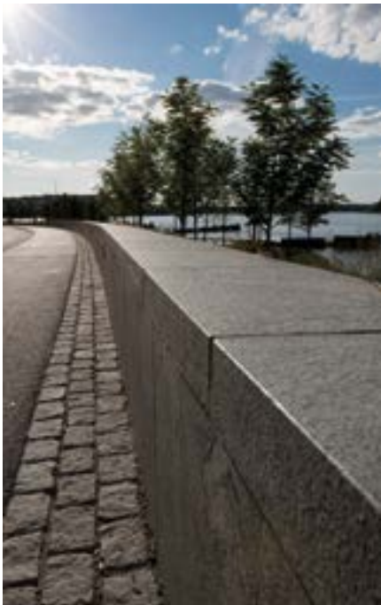
Barriärmuren mot gatan är gjuten av betong och avtäck och beklädd mot gatan av indisk gnejs. Gnejsen är vald för sitt utseende med karaktäristiska grå-vita-svarta stråk. Belysning är infälld på gatusidan. Foto Robert Kjellén
