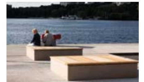
På Kajparterren finns tre sitttor som består av ett stenblock med dimensionerna 2x2 meter med sits av ek. Foto Robert Kjellén
