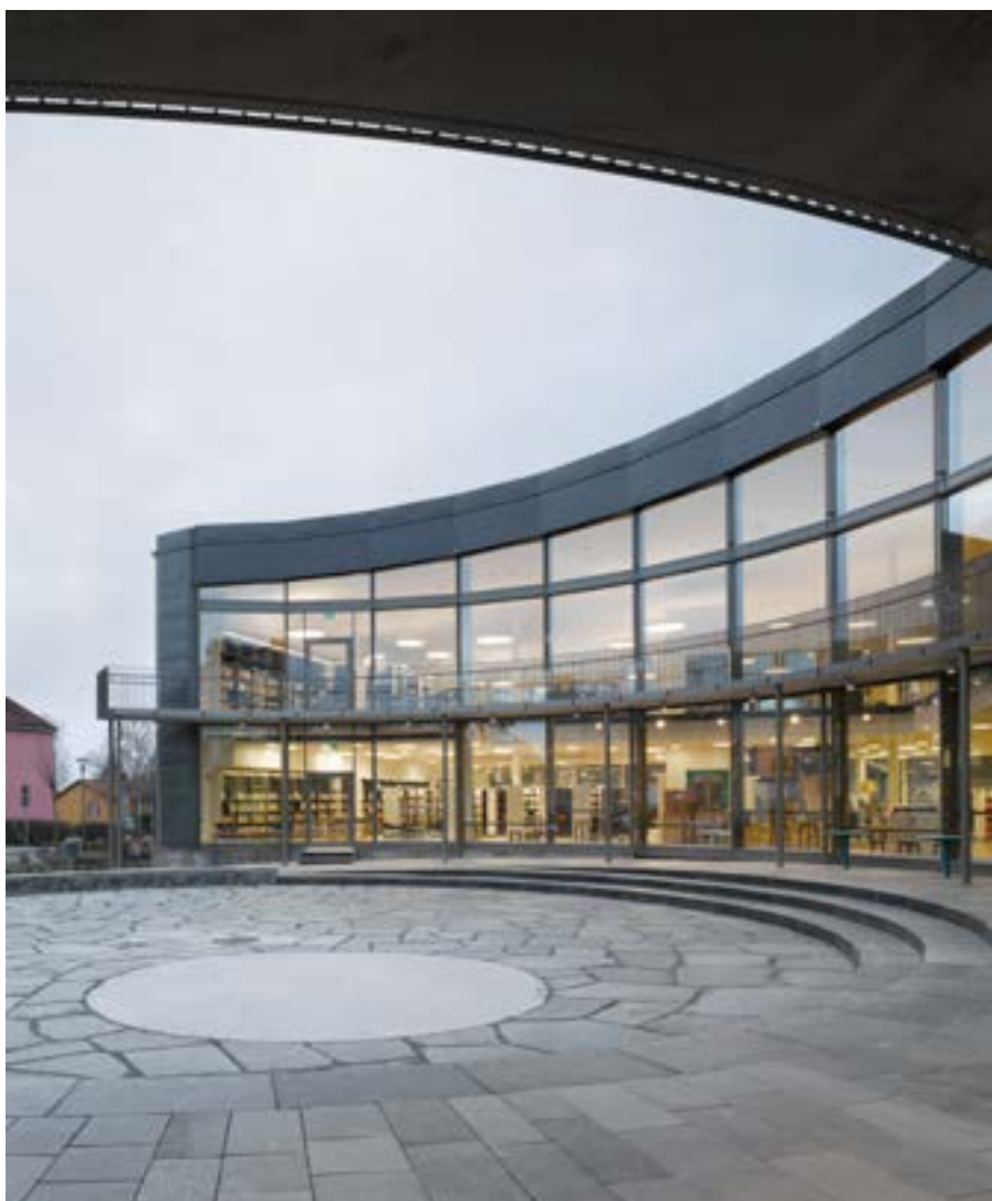
Samverkan ute- inne. Scenen i ljus terrazzo är infälld i den stora skifferytan. På sikt kommer fogarna att utgöras av gräsfog här. Foto Max Plunger
