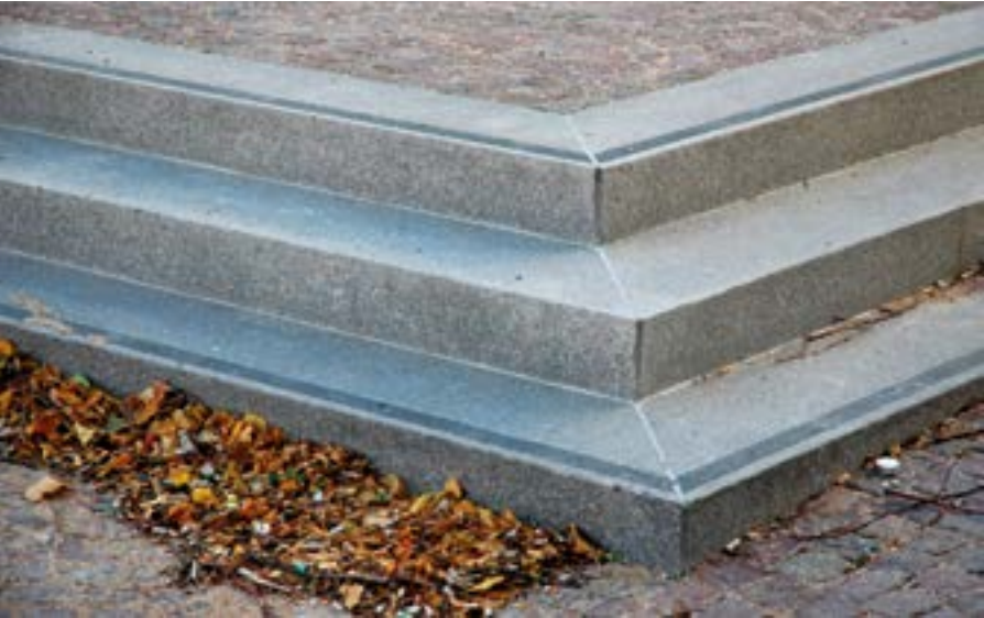
Alla trappor är utförda i flammad Näsingegranit med kontrastmarkeringar i diabas. Foto Christer Kjellén
