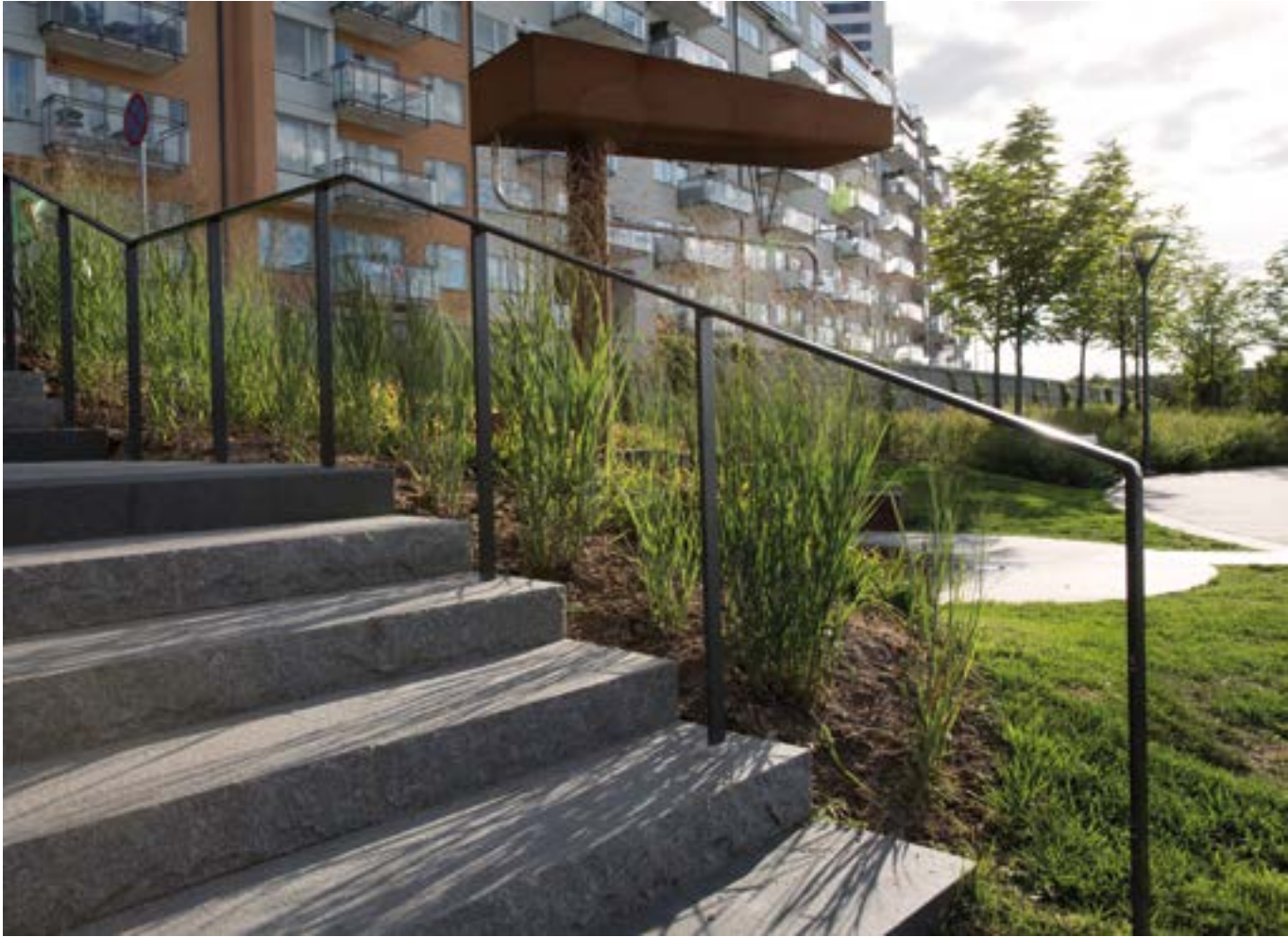
Trapporna är utförda enligt stadens krav på tillgänglighet med svart Gabbro i avvikande översteg och understeg och grå Näsinga i övrigt. I bakgrunden ser man parkens dusch med en tank där vattnet ska värmas av solen. Foto Robert Kjellén
