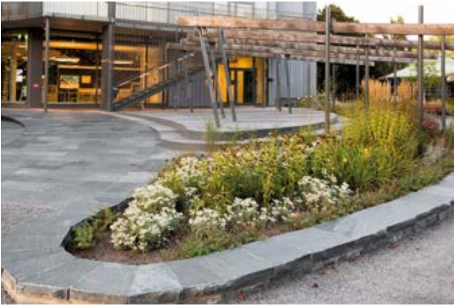
Längs med de vida gångstråken löper en 20 cm låg mur med bred krönsten, som ramar in planteringarna mot det tungformade trädäcket. Trampstenar bildar smitvägar in mot det cirkulära rummet. Foto Robert Kjellén
