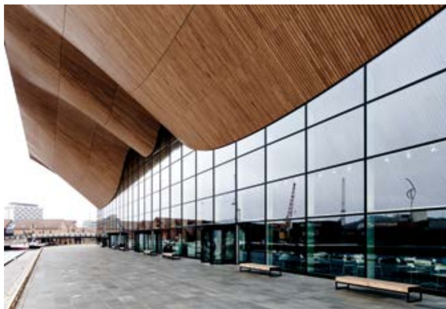
Altaskiferens høye kvartsinnhold og lave vannabsorpsjon vil gi en holdbar og vakker belegning i generasjoner. Foto Ketil Jacobsen
