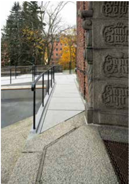
Rampens anslutning mot kyrkans ursprungliga entrétrappa. Trappans steg är i pikhuggen Vätögranit. Rampens hållar och sidor är i finsk, rödbrun Kurugranit med krysshamrad yta. Den nya konstruktionen är reversibel genom att ny sten varsamt påförts utan ändringar i det befintliga materialet.
