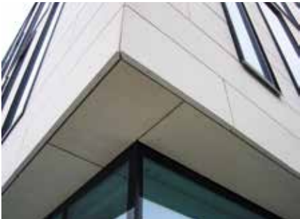
Gyldengården med sin sandstensfasad. Foto Danielsen Architecture
