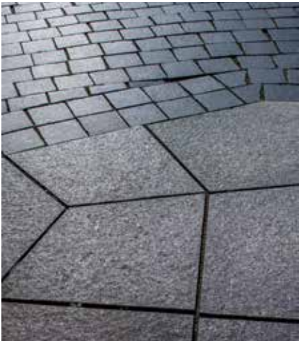
Närbild på mötet mellan mönsterläggning och den svarta smågatstenen. Foto Werner Nystrand
