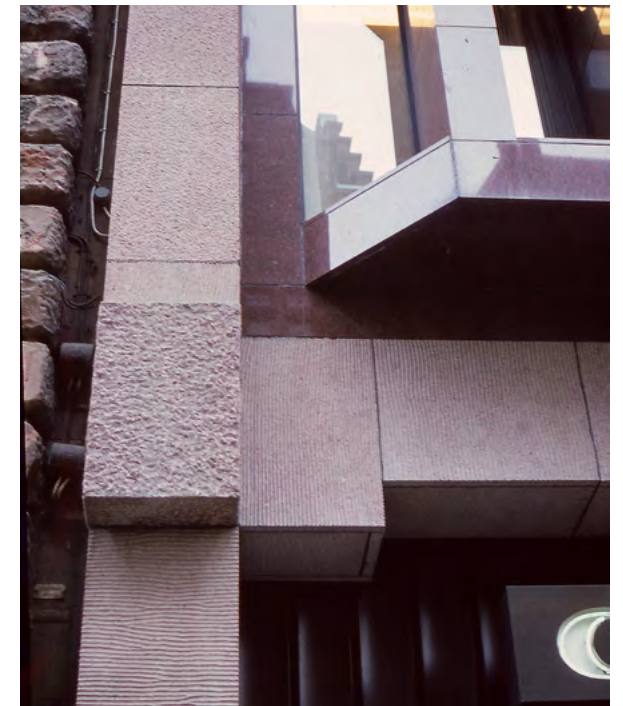
Polerad, krysshamrad, pikhuggen och randmejslad yta på samma röda granit ger kontrast i fasadbeklädnad.
