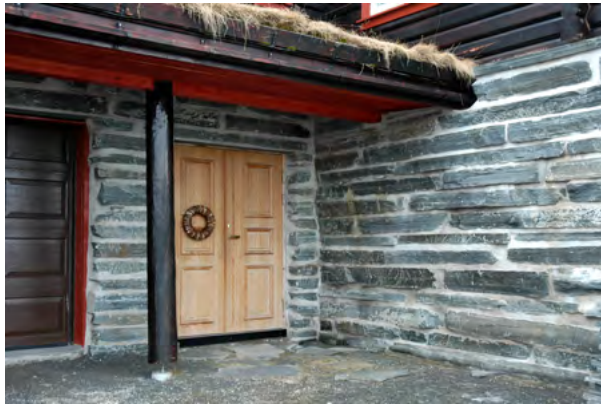
Fasad uppbyggd som bruksmur av tjocka skifferskivor med bräckt kant.
