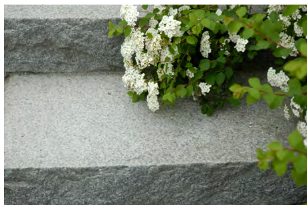
Blocksteg av granit med krysshamrad ovsida (plansteg) och råkilad framkant (sättsteg)
