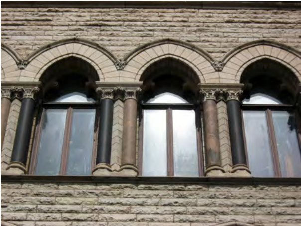
Kalkstensfasad med olika ytbearbetningar, polerade granitpelare.
