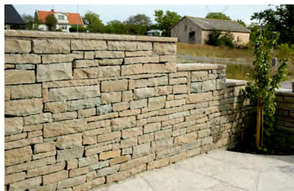
Kallmur av klippt kalksten med avtäckning där synlig kant är klippt.
