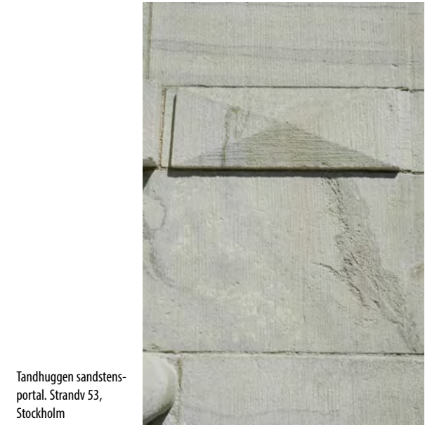
Lågerhuggen och dubbelstucken mursten, skrädhuggen list, kalksten, Strandv 53
