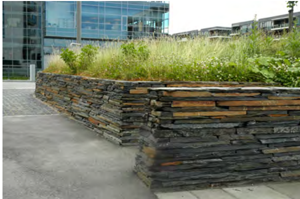
Kallmur av staplade skifferplattor med bräckt kant.
