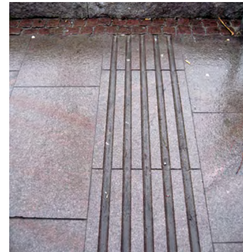
Taktila plattor av granit med frästa spår, för att markera riktningen
