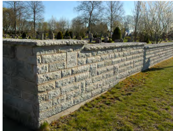
Bruksmur av dubbelstucken kalksten med avtäckning där synlig kant är dubbelstucken.
