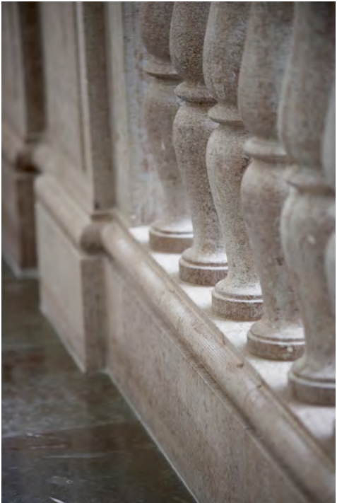
Tre olika bilder på en hantverksmässigt återskapad/rekonstruerad ballustrad av kalksten där överliggarens ovansida är slipad medan övriga ytor har tandhuggits.
