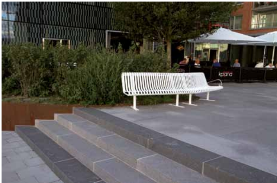
Blockstenstrappan möter den runda muren av Cortenstål. Avvikande färg på botten- och översteg som kontrastmarkering i trappan. Foto Robert Kjellén
