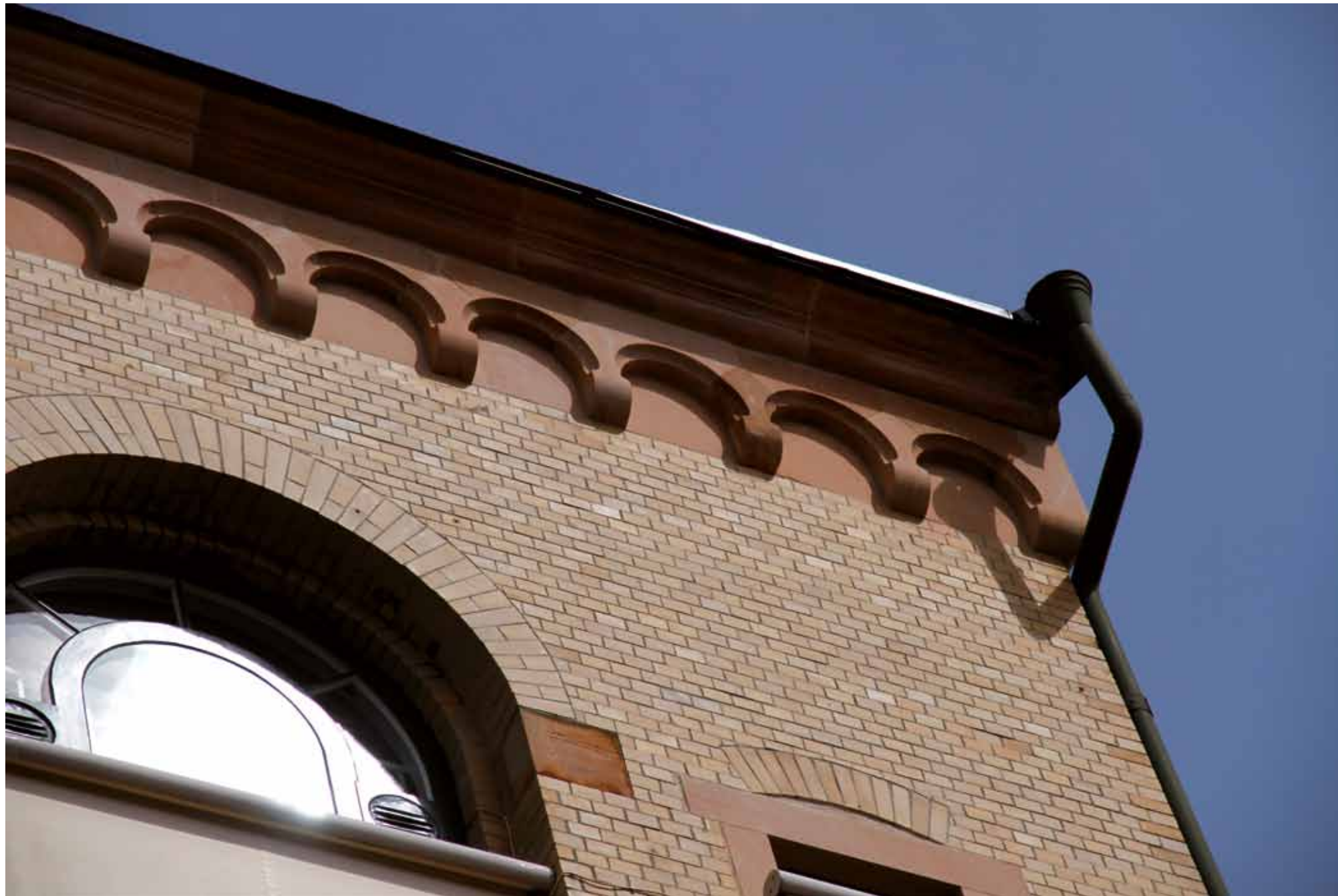
En stor del av takfotens välvda fris har bytts ut mot Orsasten. Foto Robert Kjellén
