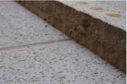
Blockstegstrappornas sättsteg är dubbelstuckna och ger med sin grovhet en fin kontrast till de subtilare detaljerna i projektet. Foto Robert Kjellén
