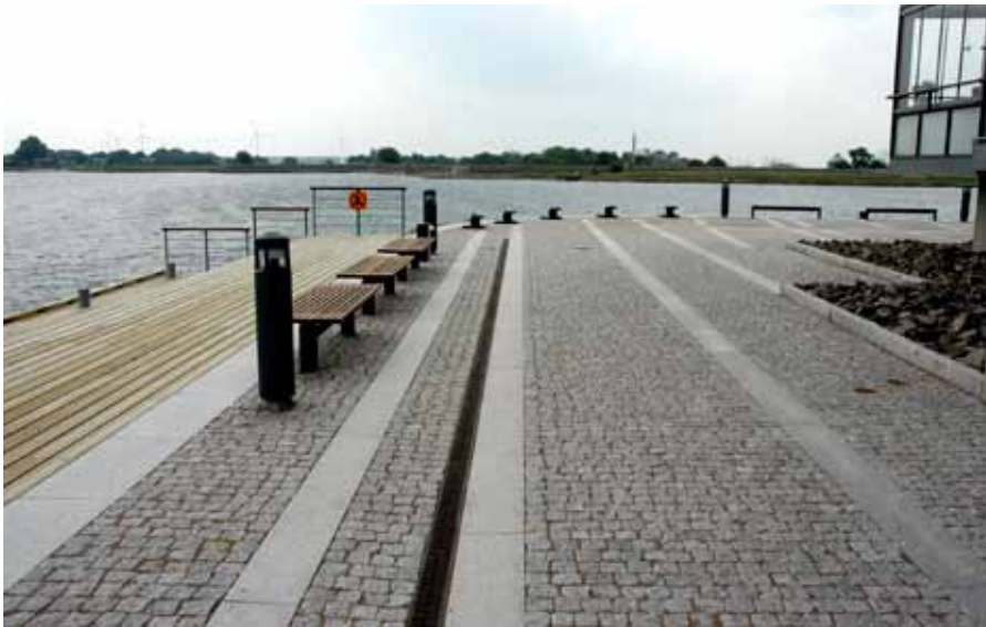
Krysshamrade markplattor och kajskoning. Råkilad gatsten.
