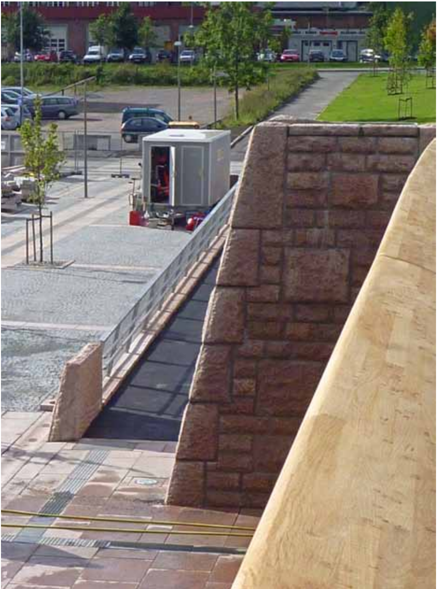
Hjørneløsning forblendet mur, med massive elementer. Foto Eivind Saxhaug
