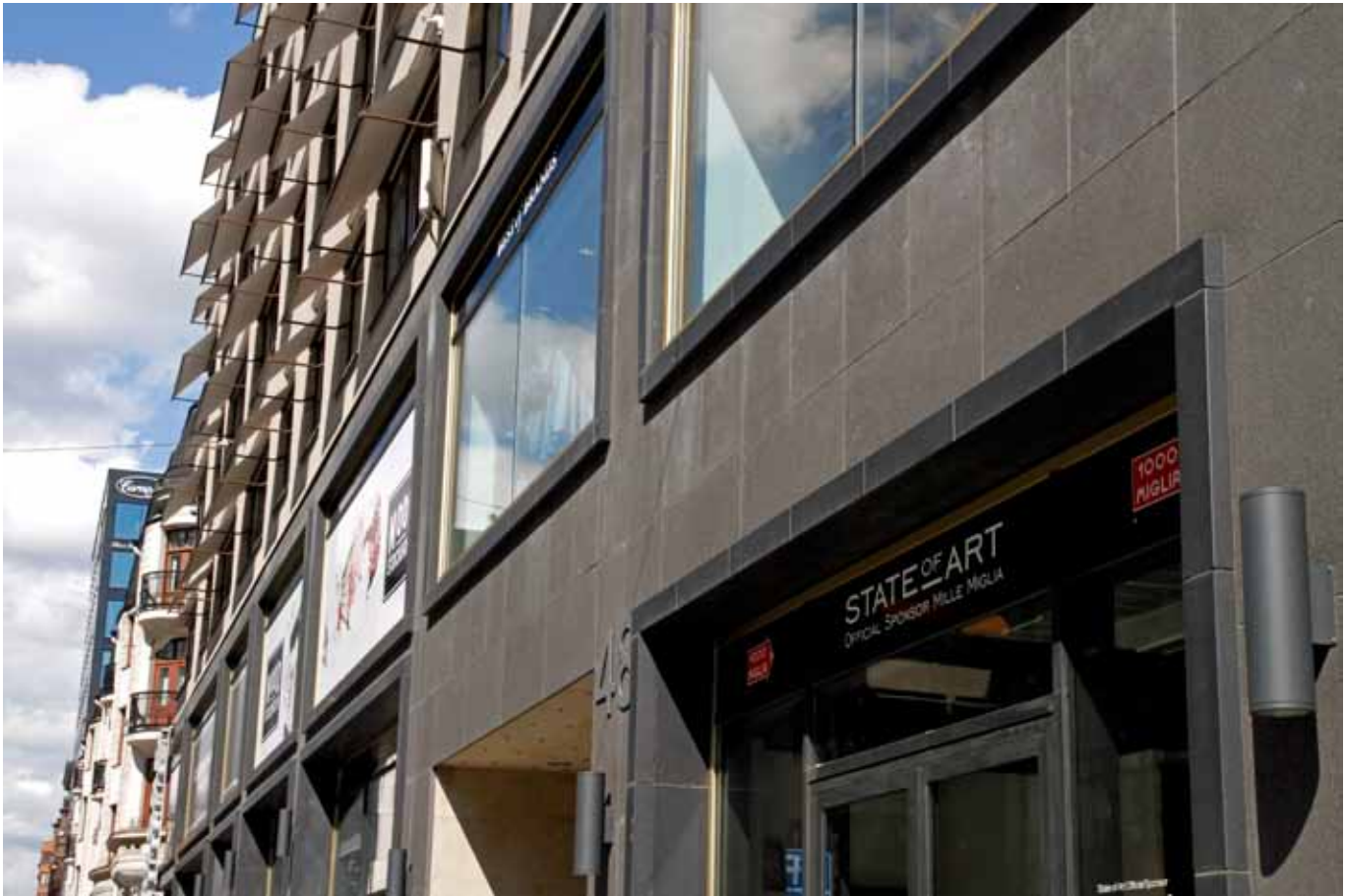
Den svarta Brännhultsdiabasen förekommer i huvudsak med flammad yta med format nära det maximala. Som omfattning i alla nya fasadöppningar är stenen utkragad och finslipad. I de nya indragna kontorsentréerna sitter kontrasterande finslipad sandsten på både vägg och tak.
