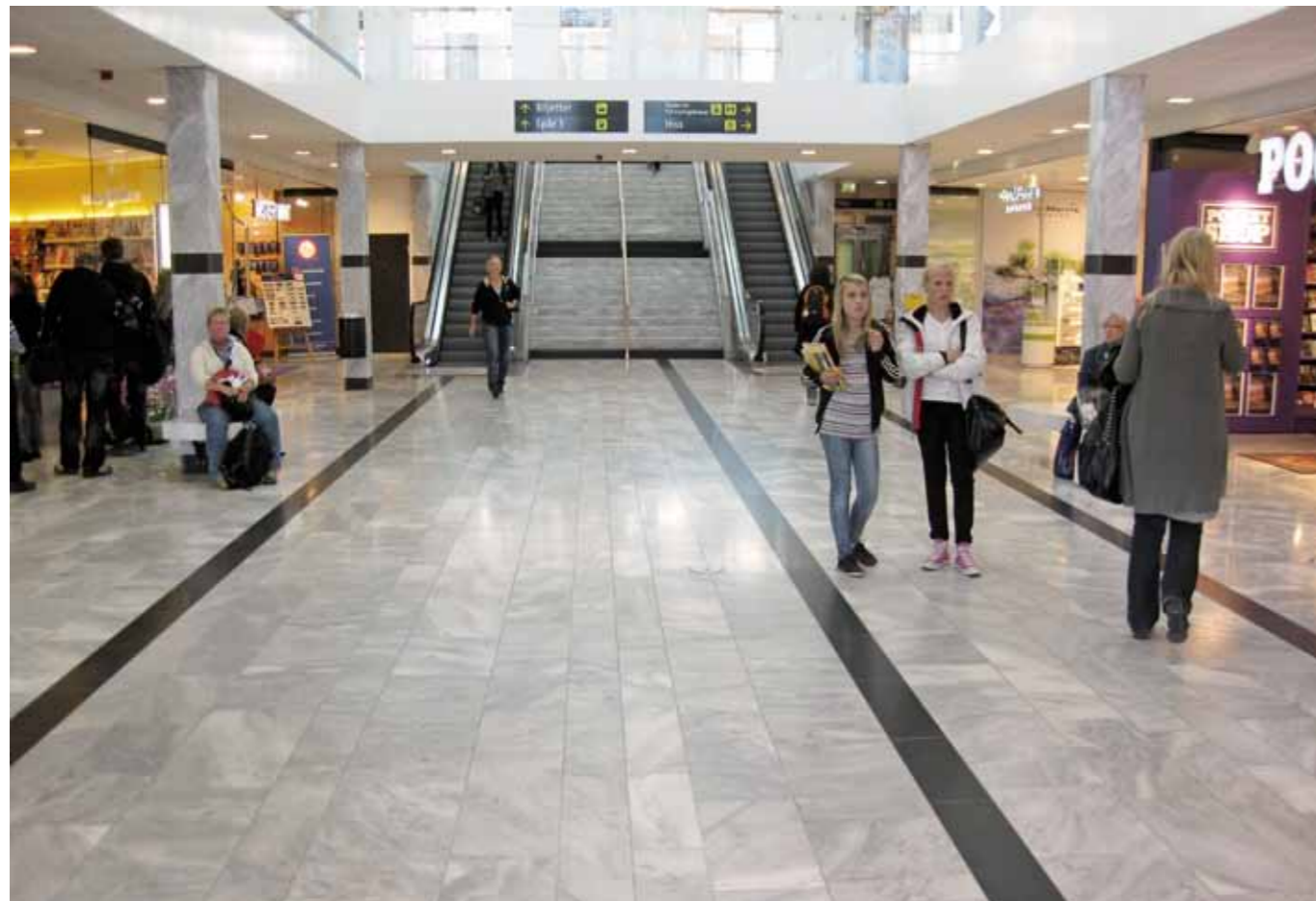
Suterrängvåningen med butiker har golv av ljusgrå marmor med infällda band av svart granit. Foto: Robert Kjellén
