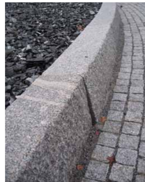
När stenens ytbearbetning är fel och när vinkeln på fasen varierar hjälper inte god montering
