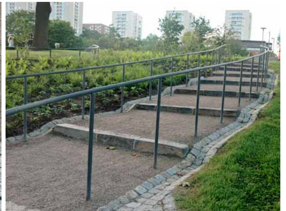
En trappväg av stenmjöl (så kallad Eco-yta, för minskad erosion) och sättsteg av svart grythytteskiffer.
