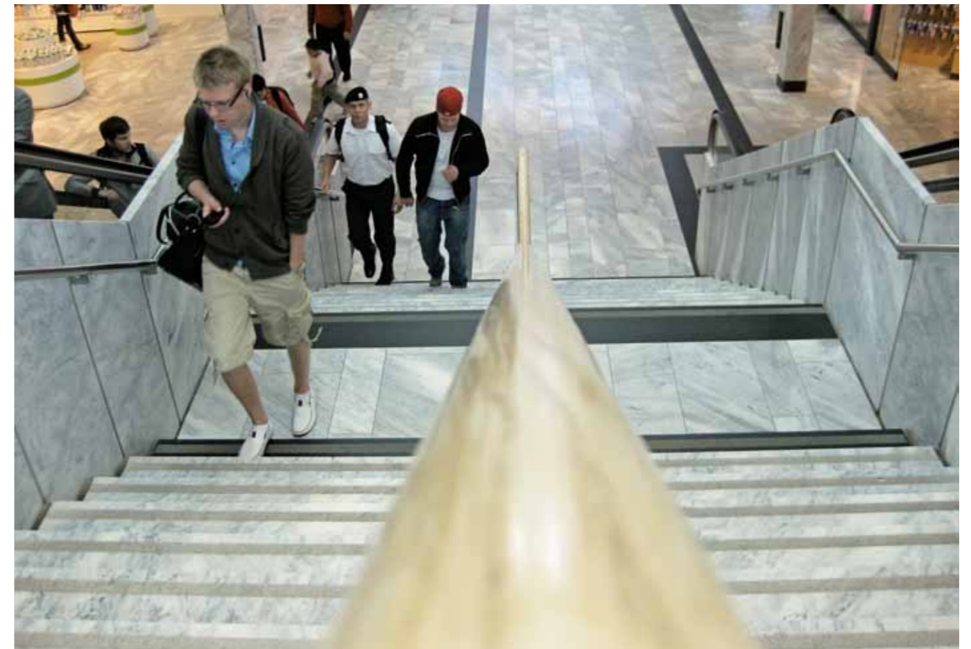
Trappan har krysshamrade band som halkskydd i planstegen. Foto Robert Kjellén
