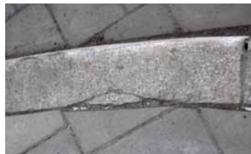
Urspjälkning på spröd sten, redan vid monteringen
