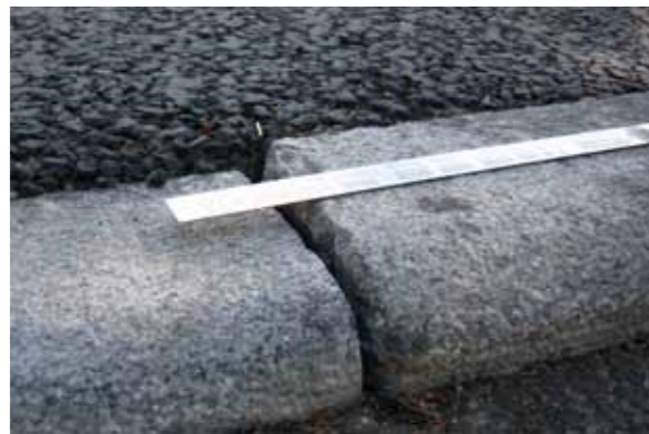
Nivåskillnad vid montering
