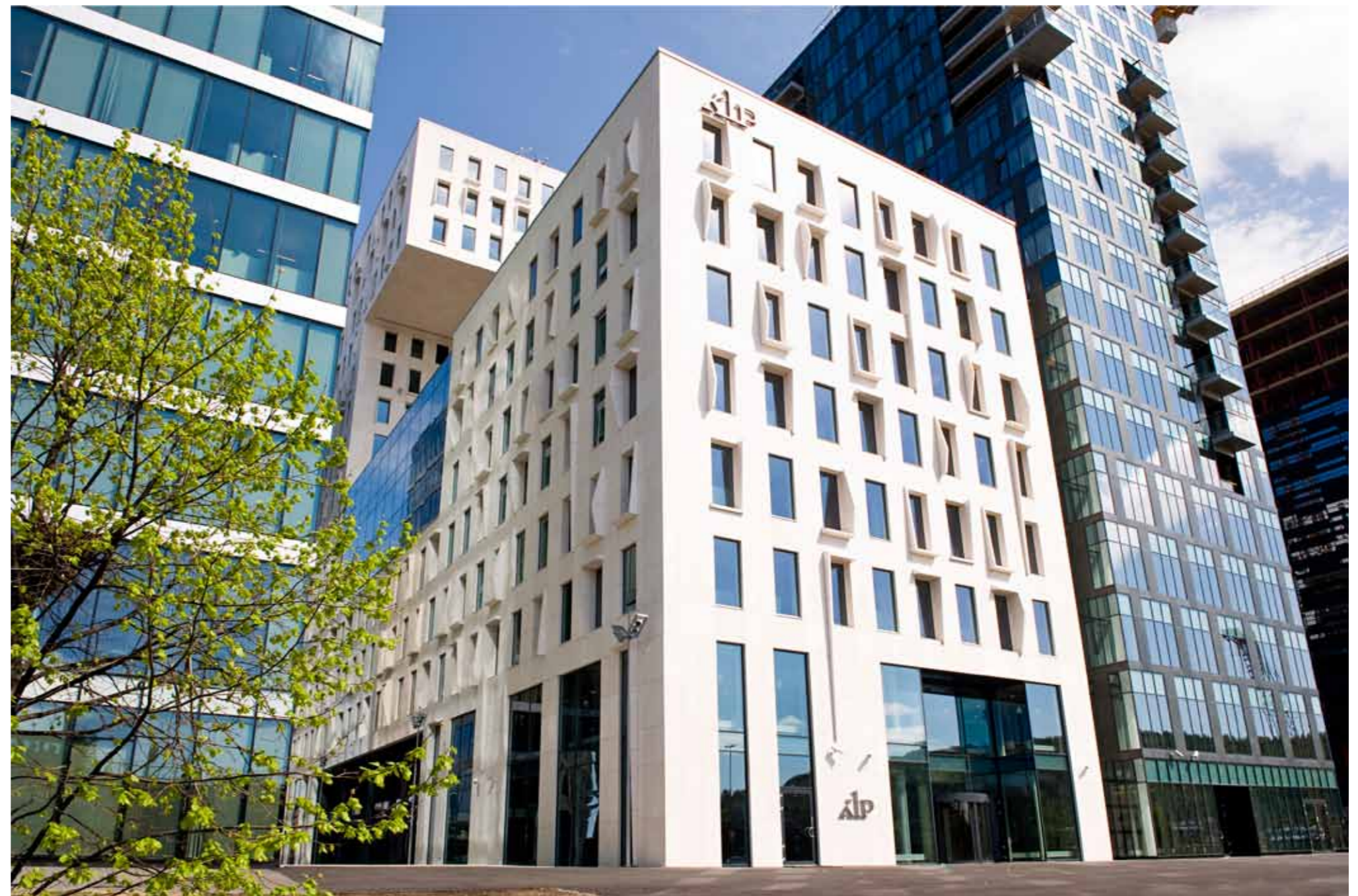
Fasade mot sjøen og opraen
