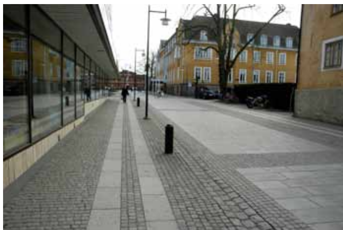
Gatstensbeläggning med gångstråk och fält av granithällar.
