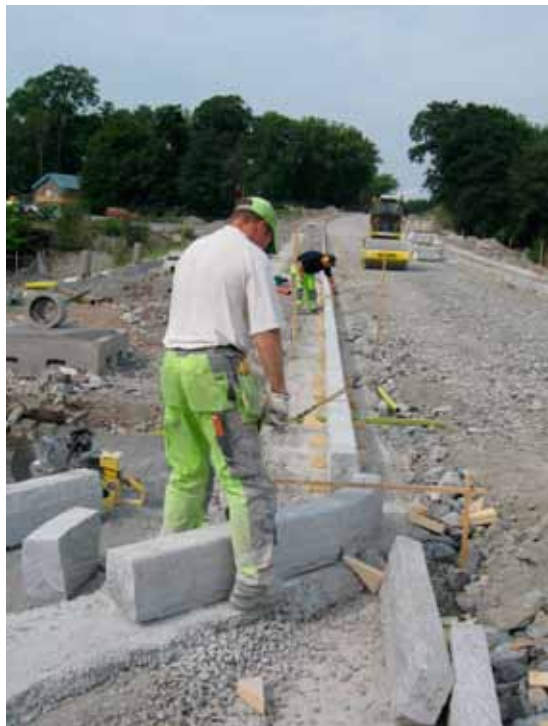
Montering av kantsten, GF1
