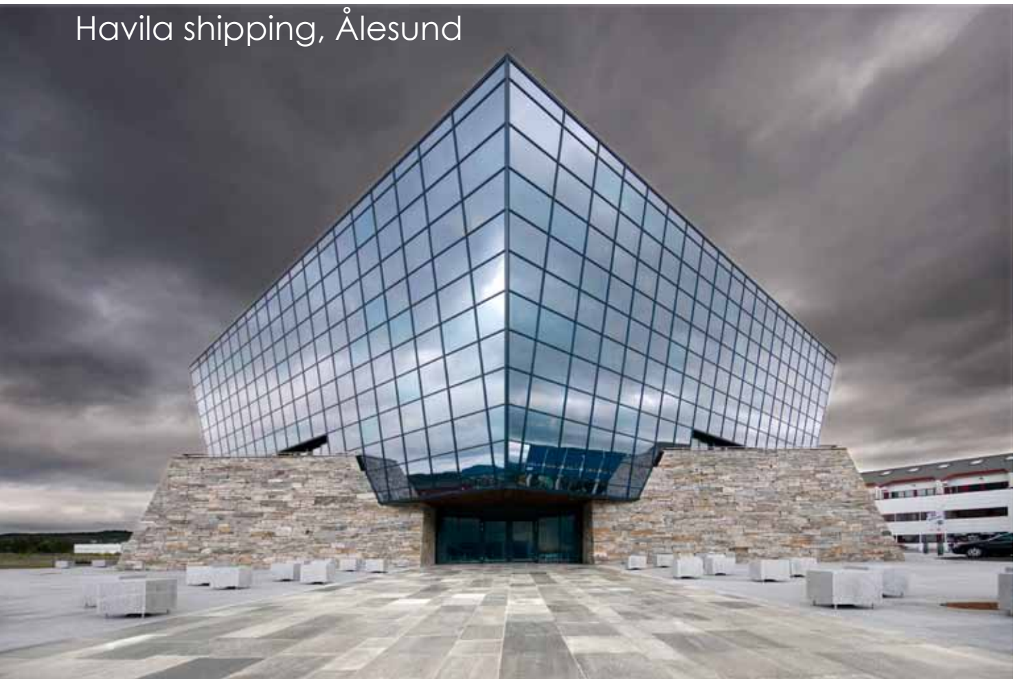
Hovedinngang mot øst med tørmur fra Norfjoreid som en sokkel, belleggningsstein av Oppdalskiifer er lagt på kaiområdet foran inngangen. Foto: Ludvig Killingberg
