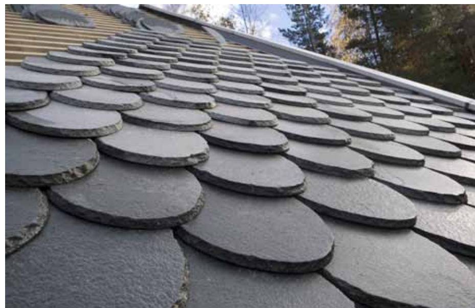
Alta lappskifer på omlegging av gammelt Tak. Foto: Profilm
