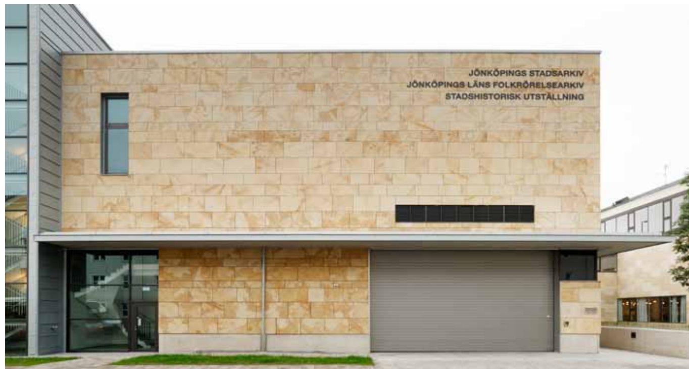
Den varmgula sandstenen är monterad med liggande band i fallande längder
