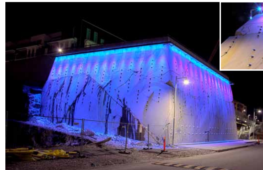
Belysningen har vi monterat i en galvaniserad balk som löper runt klippan. Den skyddar armaturena och ger samtidigt en bra avbländning. Foto: Max Kielland
