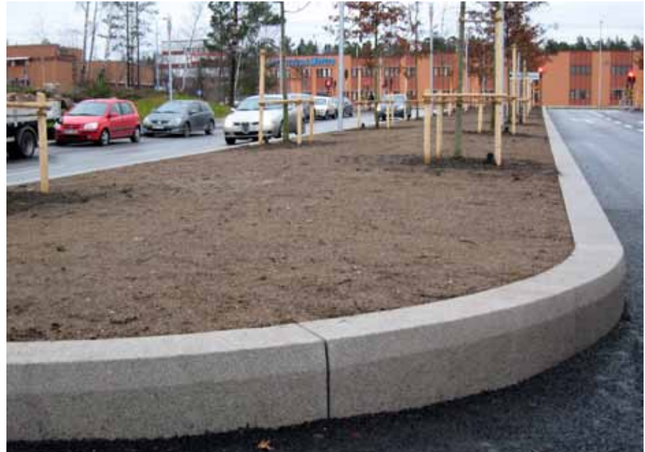
De höga kantstenarnas fasade ytor var ofullständigt krysshamrade och hade bristande måttoleranser.
