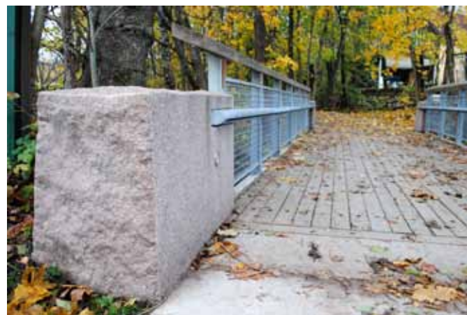
Store landkar av Røykengranitt på begge sider av gangbroene over Alna-elven. Broene har kraftige rekkverk av stål og eik, og det er innfelt LED-belysning.
