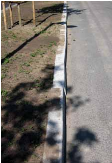
Bristande rätlinje både i sidled och höjdlid.
