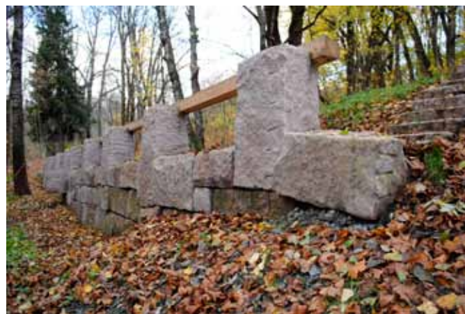
Massive bautasteiner av Røykengranitt er brukt som stolper. Sammen med innfelt handløper av eik, skilles gangvei fra terreng.
