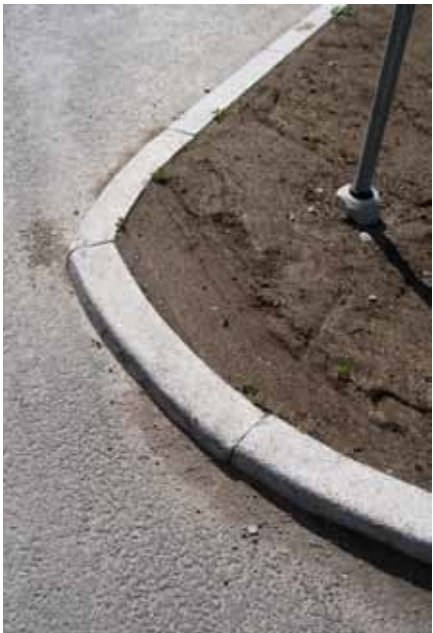
Ej fackmässigt utförd radie på kantsten.
