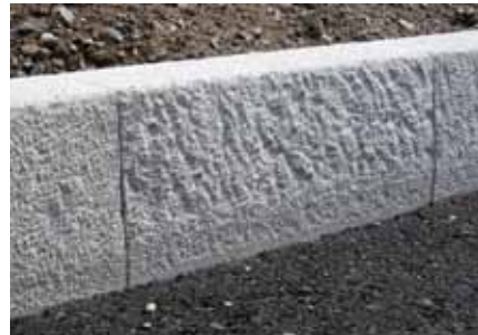
De höga kantstenarnas fasade ytor var ofullständigt krysshamrade och hade bristande måttoleranser.
