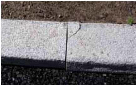
Utspjälkningar i plattkanter kan tyda på ovarsam montering, spröd sten eller en kombination av dessa faktorer.
