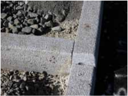
Synliga ändrar på kapade stenar ska överhuggas och ej visa den sågade ytan.
