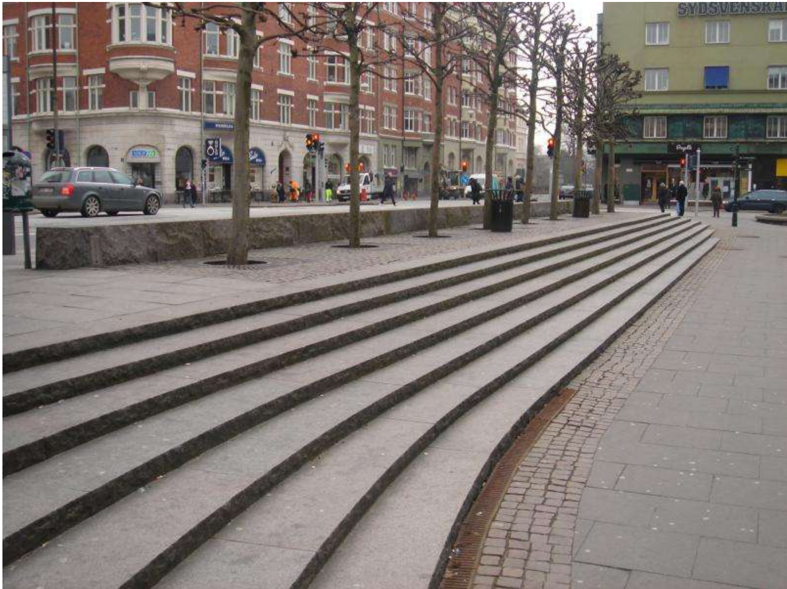
Rätt stenval: 19 år utan underhåll (Bjärlövgranit)
