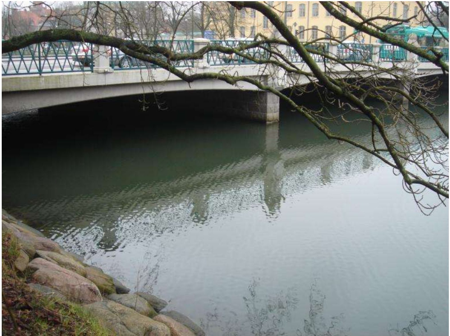
Lyckosam kombination: Betongbro klädd med tunn råkilad granit 44
