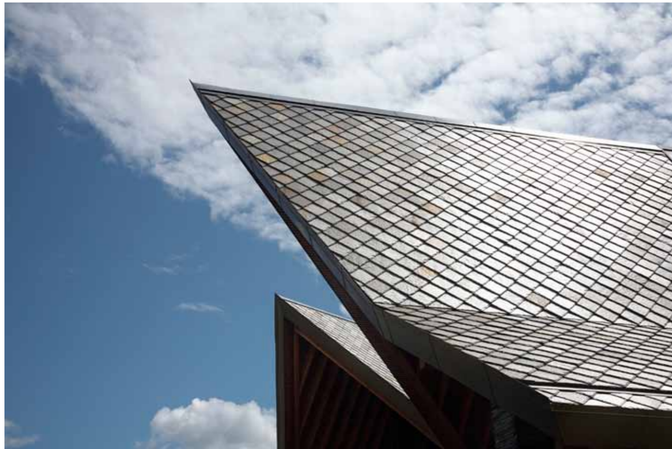
Takene er det belagt med klipt 15" x 15" firkantstein i Ottaskifer med naturplan. Foto Thorbjørn Hansen
