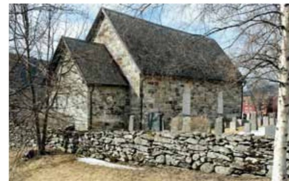
Fig 1.13 Åre gamla kyrka från slutet av 1100-talet. Lokalt skiffer som grova block i väg-garna och som takbeläggning.
