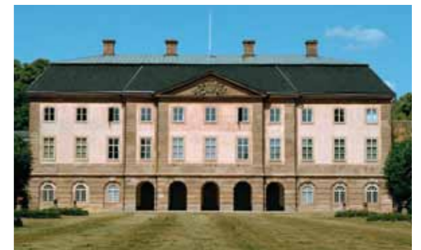
Fig 1.20 Övedsklosters slott, ritat av Carl Hårleman och uppfört under 1760-talet. Rokokons fasader är ofta försiktigt modulerade med risaliter. Mot den rosa putsade fasaden står souterrängväning, lisener, fronton och takgesims av lokal röd Övedssandsten.
