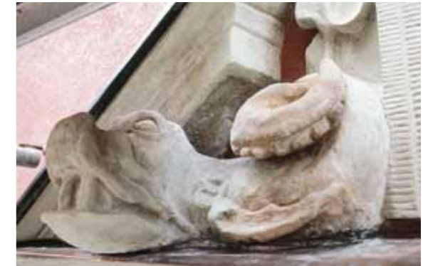
Fig 4.11 Samma drake som ovan, efter konservering utan tillägg.
