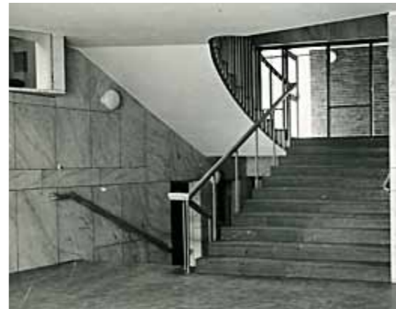
Fig 1.37 Väggbeklädnad av Ekebergsmarmor utförd 1952. Handelshögskolan i Göteborg.
