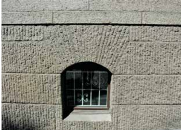
Fig 7.6 Sockel av randmejslad granit. Ovanför sockeln är graniten krysshamrad, grad 1. Eriksbergsgatan 44, Stockholm.
