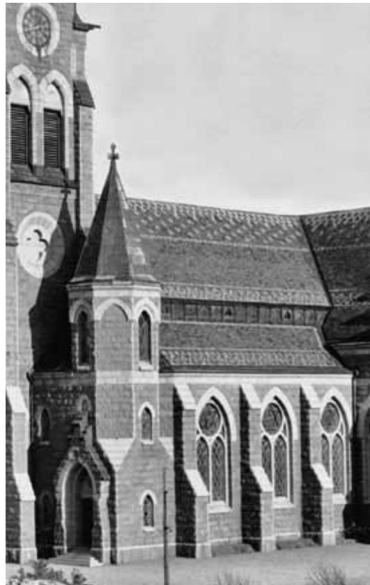
Fig 5.2 Lysekils kyrka, uppförd 1899-1901, fick en exteriör helt i granit. Taket belades med svart Grythytteskiffer och med mönster av ljusare Glavaskiffer.
