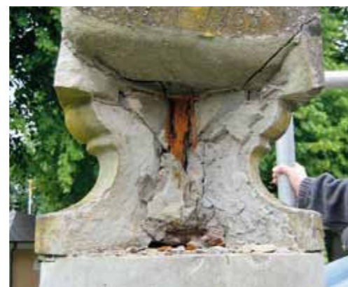
Fig 3.32 Korrosionssprängningar i solur. Almunge kyrkogård, Uppland.
