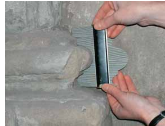
Fig 4.2 Vid mallning med profilkam måste man ha klart för sig att den vittrade stenen inte ger rätt profil. Mätten måste justeras till ursprunglig form. Mallprofilen bör godkännas av antikvarisk kontrollant.
