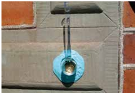
Bild2.9 Mätning av vattenupptagning med Karstens rör. Vadsbro kyrka
