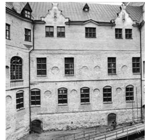
Fig 1.58 Gripsholms slott från sekelskiftet 1900, efter Fredrik Lilljektiv restaurering. Längorna har byggts på med ett våningsplan. Fasaden har fått en ljus puts med dekor kring fönstren och under takfoten. Den grova putsrustiken har kopierats efter Kung Jans port på Uppsala slott.
