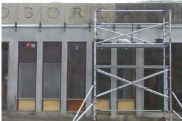
Fig 1.34 Rengöring med varmvatten och högtryck på ljus Ekebergsmarmor vid Eslövs medborgarhus.
