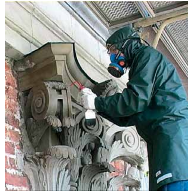
Fig 4.9 Konsolidering med kiselsyraester. Riddarhuset, Stockholm
