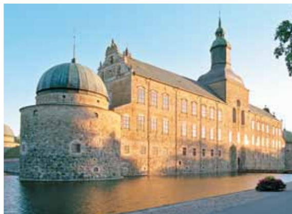
Fig 1.17 Vadstena slott är ett av landets bäst bevarade renässansbyggen; en sluten försvarsanläggning med massiva murar av kalksten och olika sorters lokal fältsten. Murarna har varit putsade. För den påkostade portalen och gavelkrönet användes kalksten, möjligen från Borghamn.
