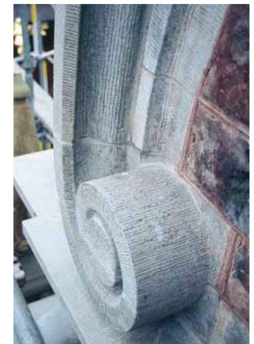
Fig 4.19 De nyhuggna delarna har monterats och tandhuggits på plats i likhet med den ursprungliga.
