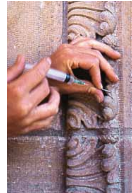
Fig 4.3 Säkring genom injektlimning. Gamla Krematoriet, Örebro.
