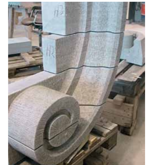
Fig 4.18 Den nyhuggna voluten och del av nytt krön inne på verkstaden.
