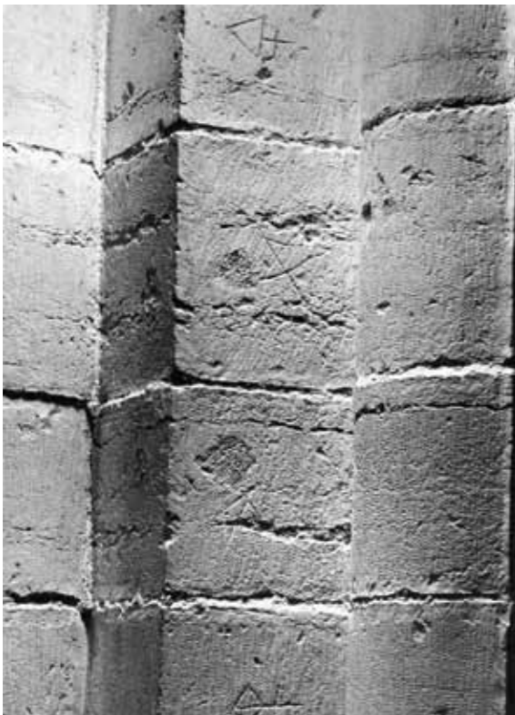
Fig 2.2 Historiska dokument är bärare av information. En över 700 år gammal tandhuggen kvadersten från Linköpings domkyrka bär vittnesbörd om den tidens nya bearbetningsteknik. Genom konserveringen bevaras originalmaterialet som källa till kunskap för dagens och morgondagens samhällen. En utbytt sten är också ett historiskt dokument, men den vittnar inte om objektets ursprungliga historia utan om dess restaureringshistoria.
