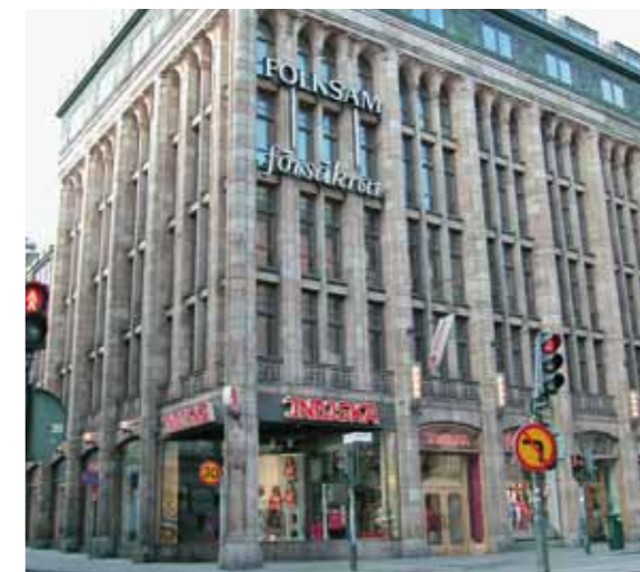
Fig 1.27 Affärs- och kontorshus på Kungsgatan i Stockholm byggt 1910 som en skelettkonstruktion av armerad betong, med tillagd fasad av Grännasandsten. Glaspartierna ramas in av smala pelare och bjälklagsmarkeringar av sandsten.
