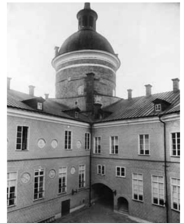
Fig 1.57 Inre borggården på Gripsholms slott omkring 1870. En våning hade rivits i början av 1700-talet. De putsade fasaderna är sedan 1800-talets början målade i tegeldecor.
