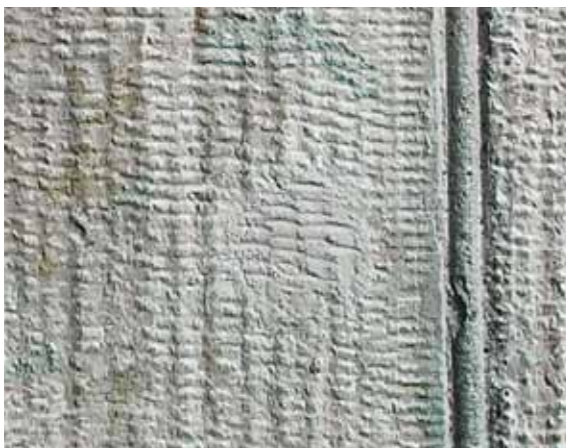
Fig 4.14 Lagning av hål och ytbearbetning som liknar befintlig sten. Storgatan, Stockholm.
