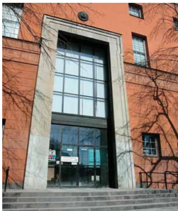
Fig 1.28 Under 1920-talets klassicism var murarna åter putsade, men naturstenen exponerades desto mer påtagligt i trappor och portaler. Stadsbiblioteket på Sveavägen i Stockholm med portal av Kolmårdsmarmor.
