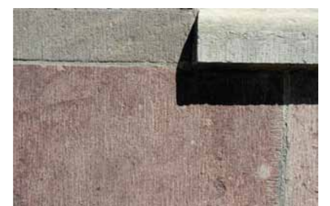
Fig 7.15 Skrädhuggen Roslagssandsten i murverk och tandhuggen kalksten i solbänk. Strandvägen 45, Stockholm
