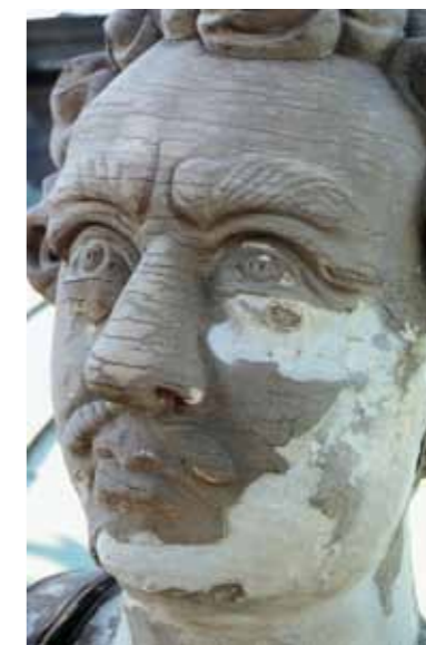
Fig 1.61 Skulptur, Riddarhusets tak, södra sidan, av gotländsk sandsten. Behandlad med kasein första halvan av 1900-talet. Det behandlade ytskiktet krackelerar och spjälkas.
