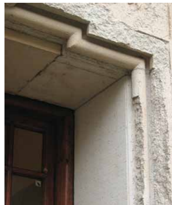
Fig 3.18 Stora materialförluster på grund av klovförsvagning. Högbergsgatan 11, Stockholm.
