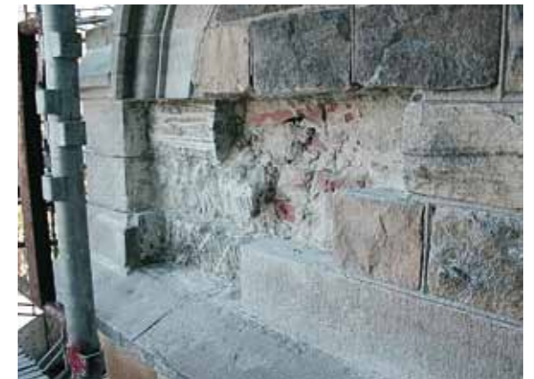
Fig 4.17 Byte av sten på Nordiska museet, Stockholm. Murverket på gavelröste efter demontering av en skadad volut.
