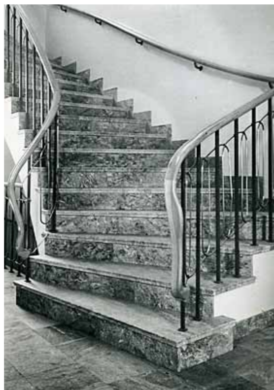
Fig 1.30 Trappa och golv av grön Gropptorpsmarmor i Medicinska Nobelinstitutet i Stockholm, byggt 1948.
