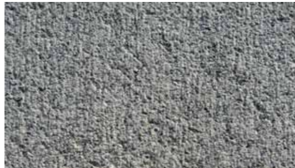
Fig 7.8 Detalj av den räffelhamrade ytan på Riksdagshuset.
