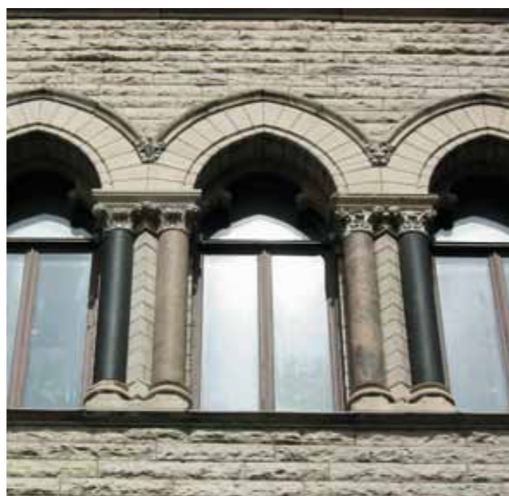
Fig 1.23 Fasaden får sin dekorativa verkan av stenens kontrasterande stensorter med olika kulör och bearbetning. Murverk av ljus kalksten. Mellan fönstren kolonner av svart och röd granit. Munkbron 9 i Stockholm.
