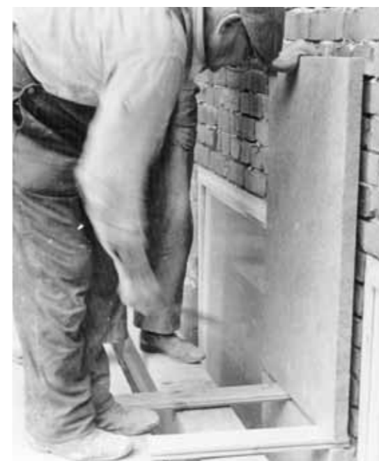
Fig 1.33 Montering av stenplattor mot bakmur av tegel, 1940-talet.
