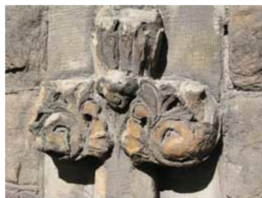
Fig 3.17 Tunn krusta på gottländsk sandsten. Kv Matrosen, Stockholm.
