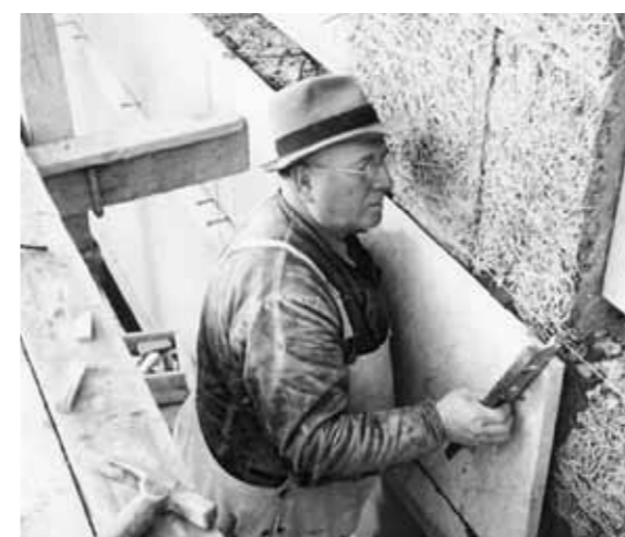
Fig 1.32 Montering av stenplattor på fasad isolerad med träull, 1940-talet.
