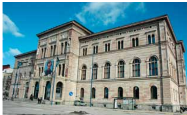
Fig 1.22 Nationalmuseum, uppfört 1846-66, ansluter till norditaliensk renässans. Putsarkitekturen dominerade vid den tiden, men för det betydelsefulla museibygget användes kalksten från Borghamn som fasadbeklädnad.
