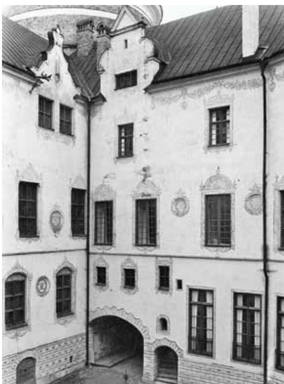
Fig 1.59 Åren 1965-67 gjordes en byggnadarkeologisk restaurering av Gripsholms slott. I sin nit att avlägsna Lilljekvist historicism knackade man ner även 1500-talsputsen. Borggården fick ett utseende den aldrig tidigare haft.
