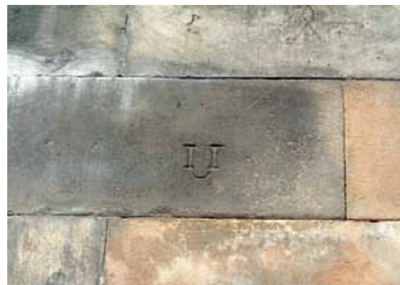
Fig 4.20 Mats Johansson Dalby Stenhuggeri, har satt sitt märke på en utbytt sten. På den gamla stenen ovanför skymtar ett äldre stenhuggarmärke.
