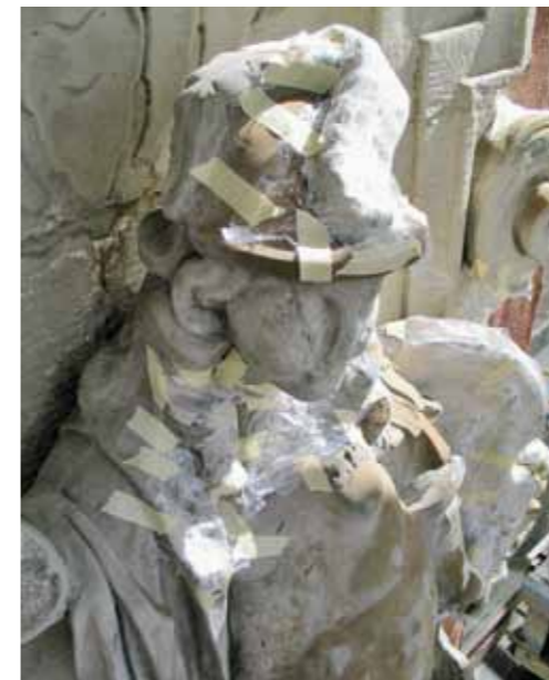
Fig 4.6 Partiell lerinpackning. Petersenska huset, Munkbron, Stockholm.
