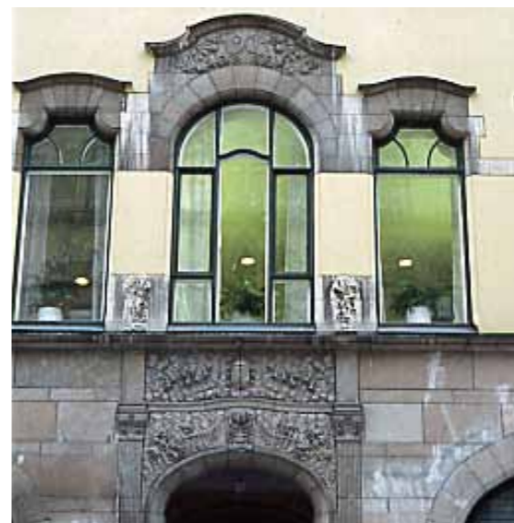
Fig 1.26 Bostadshus med putsad fasad, och sockelväning, portal och fönsteromfattningar av röd sandsten i tidstypisk jugendstil. Esplanaden nr 11 i Sundsvall.
