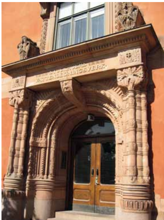
Fig 1.50 Sthlms Vattenverk, Torsgatan, Stockholm, byggnadsår 1906. Arkitekt Ferdinand Boberg och Gustaf de Frumerie. Röd sandsten
