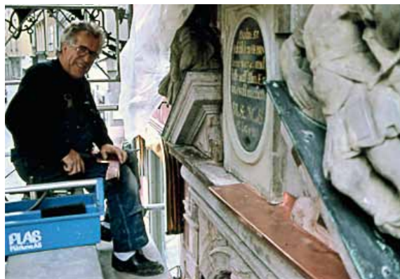
Fig 4.24 Avtäckning med kopparplåt på gesims, Stortorget i Stockholm.
