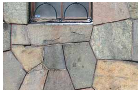
Fig 1.25 Polygonmur av noggrant utvalda granitblock med barkyta. Tryckt fog ca 10 mm. Eriksbergsparken, Stockholm.
