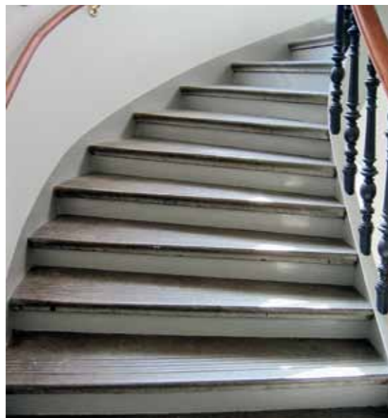
Fig 1.42 Plansteg av kalksten på stomme av gjutjärn från 1885. Tyskbagargatan 12, Stockholm.
