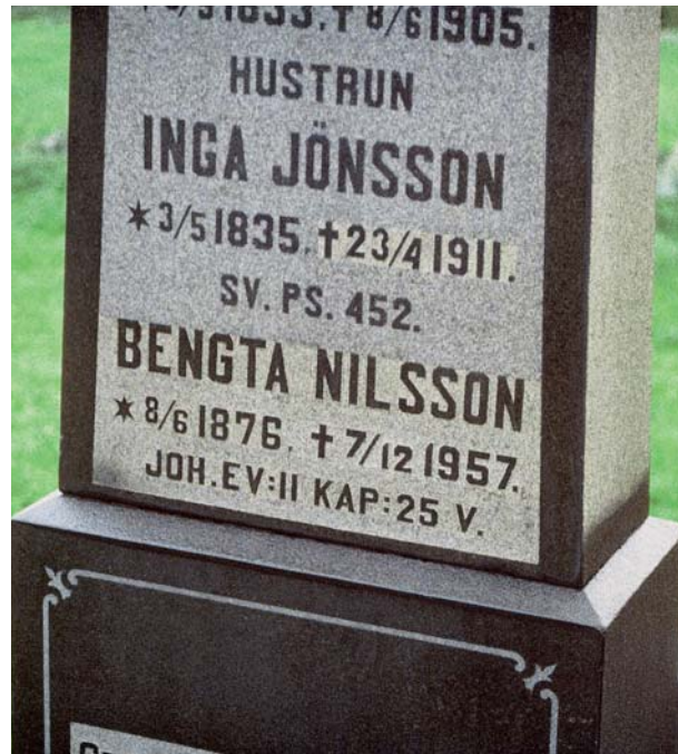
En gravvård textkompletterad på plats på kyrkogården, hantverksmässigt, 1911 och 1957. Texten är från början upphöjd polerad på blåstrad botten medan kompletteringen skett för hand med mejsel.
