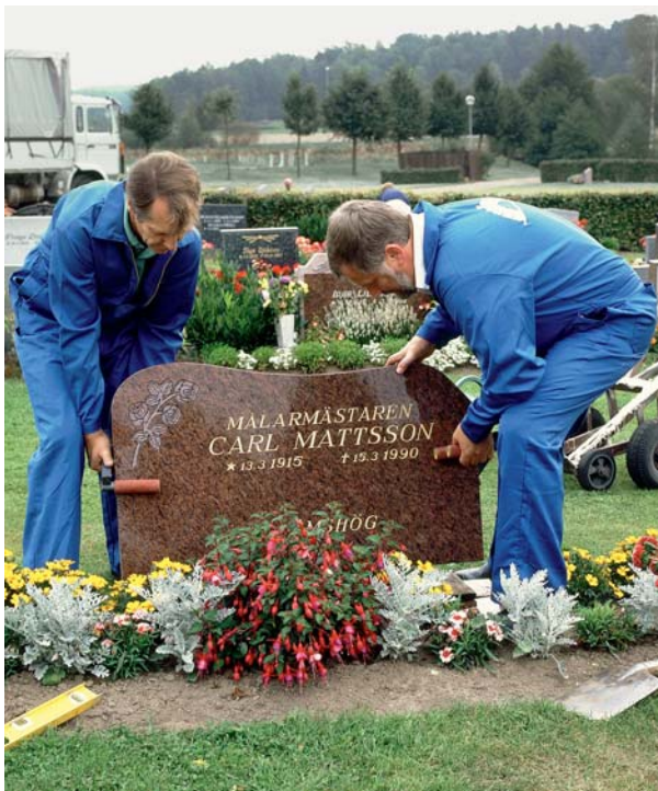
Gravvård monteras på synlig sockel efter grundläggning.
