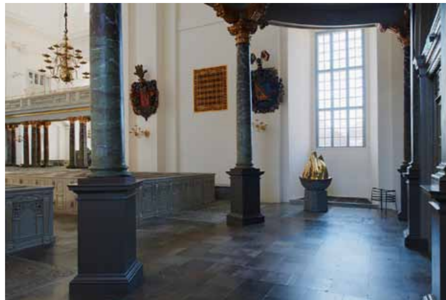
I kyrkorummets västparti har ett "kyrktorg" frilagts med komplettering av finslipad ölandssten.
