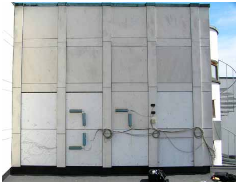
Fältprovningsplats på taket av stadshuset
