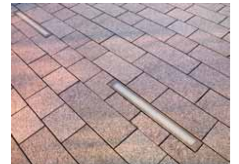
Det helhetlige natursteinsdekke med innfelt belysning gir torget et moderne preg.
