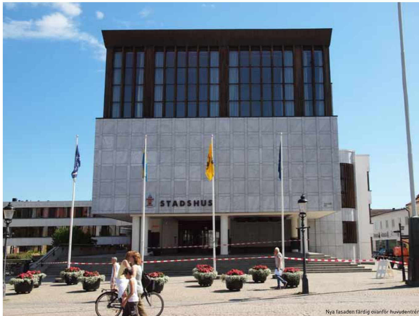
Nya fasaden färdig ovanför huvudentrén
