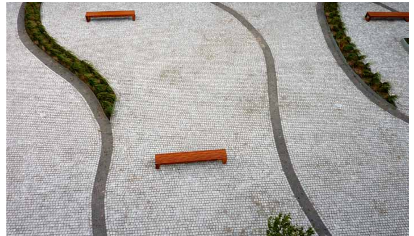
Innergården med sin markbeläggning av smågatsten får sin dynamik av de böljande ränderna av svart mosaiksten. Foto Linda Andsberg
