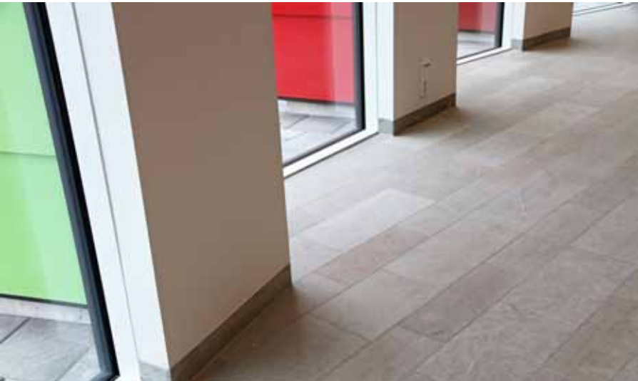
Infällda socklar av kalksten i entréplanet. Foto Robert Kjellén
