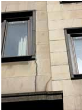
Underkant burspråk var fasadplattor av Ekebergsmarmor spräckta och listverk av Fjäråsgnejs förskjutna. Foto Christer Kjellén
