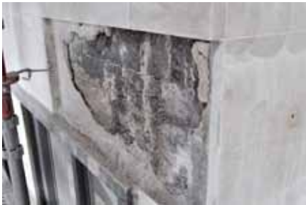
Spräckt platta har demonterats. Foto Marmor & Granit
