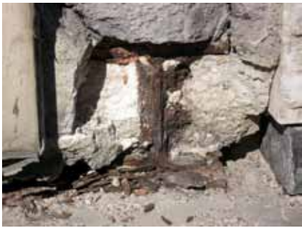
Bärande balk som bar upp burspråket med kraftiga rotskador. Det gick att plocka flagor med bara fingrarna. Foto Christer Kjellén
