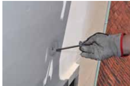
Syrafast, rostfri dubb monteras. Foto Marmor & Granit
