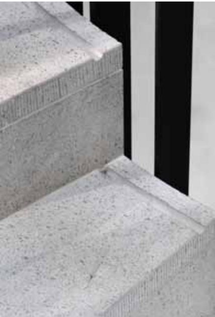
Huvudtrappan i kalksten med lågerhuggen kant på planstegen. Foto Robert Kjellén
