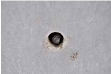
Säkringsdubb, infälld i stenytan. Foto Marmor & Granit
