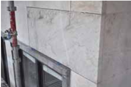
Ny ersättningsplatta av Ekebergsmarmor. Foto Marmor & Granit
