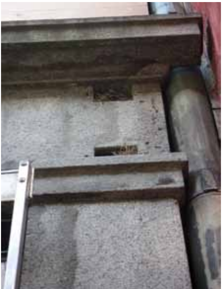
I bottenvåningen fanns bland annat hål efter infästningar och installationer. Foto Christer Kjellén
