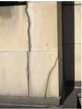
Underkant burspråk var fasadplattor av Ekebergsmarmor spräckta och listverk av Fjäråsgnejs förskjutna. Foto Christer Kjellén
