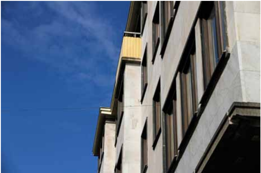
Marmorfasaden har återfått sitt ursprungliga utseende. Skillnaden i kulör och textur mellan nymonterade plattor och befintliga är minimal. Fasaden upplevs som en enhet. Foto Robert Kjellén
