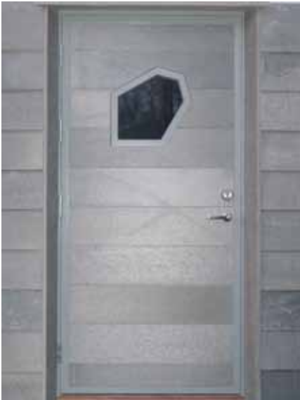
Designet dør laget for å tåle vekten av oppdalsskiferen i front, vindu formet som enTrællHelle.
