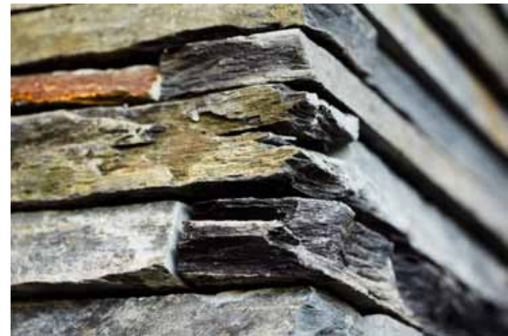
Tørrmurene i Ottaskifer har en naturlig eller klipt visflate (kant). Steinene er nøye sortert og har en maksimal dybde på 7,5 cm. Tykkelsen (høyden) er 2-5 cm og lengden fra 30 cm og oppover. Illustration Henning Larsen Architects Foto Thorbjørn Hansen
