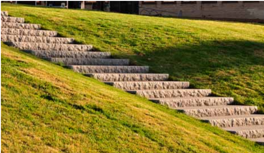
Nivåskillnaden på drygt fyra meter mellan terrasserna och sjön tas upp av en enda lång trappa, med blocksteg av Ävjagranit. Trappan är nedgrävd och följer konturen av grässlätten, endast trappnosarna är synliga.
